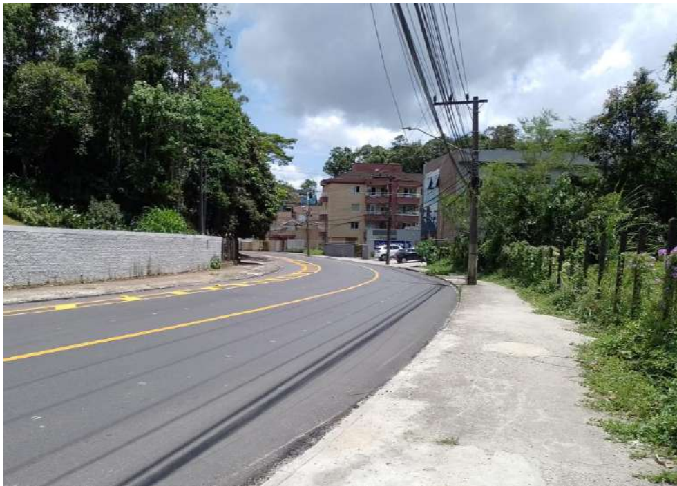
Figura 23: Postes de iluminação pública na rua Copacabana, sentido rua Farroupilha/Anita Garibaldi.
