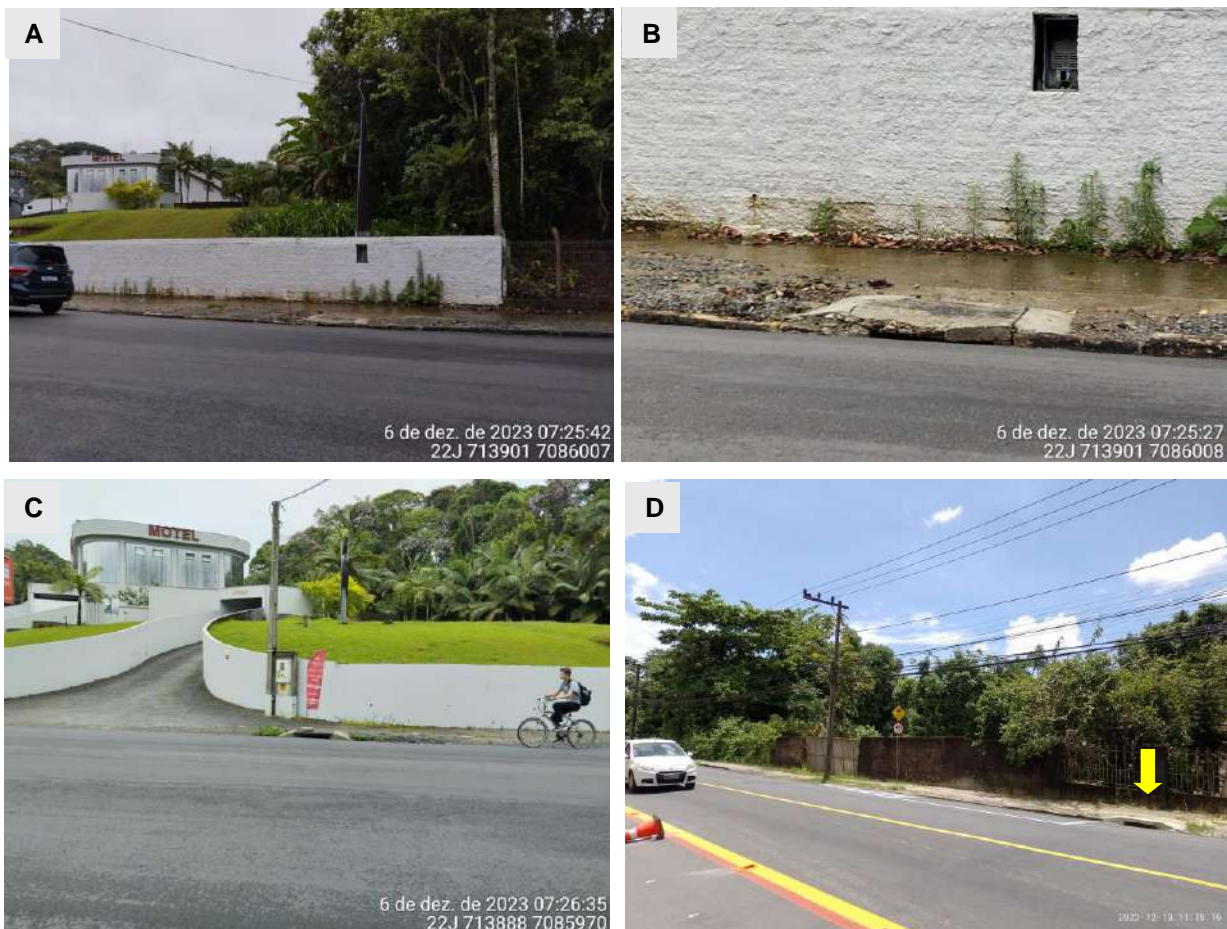
Figura 20: Bocas de lobo para coleta de água pluvial na rua Copacabana. A: Lado oposto da rua, frente ao imóvel; B: detalhe; C: Lado oposto da rua, frente ao imóvel; D: Mesmo lado da rua, próximo ao imóvel.
