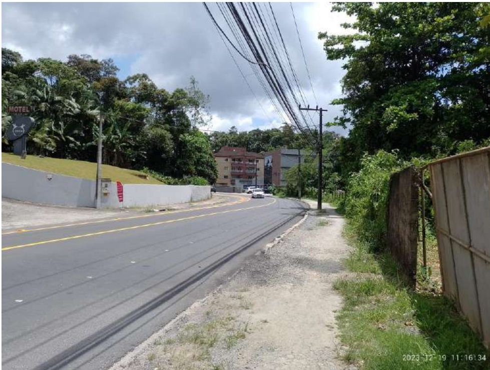
Figura 13: Rua Copacabana, em frente ao imóvel, com pavimentação asfáltica e calçada com avarias.
