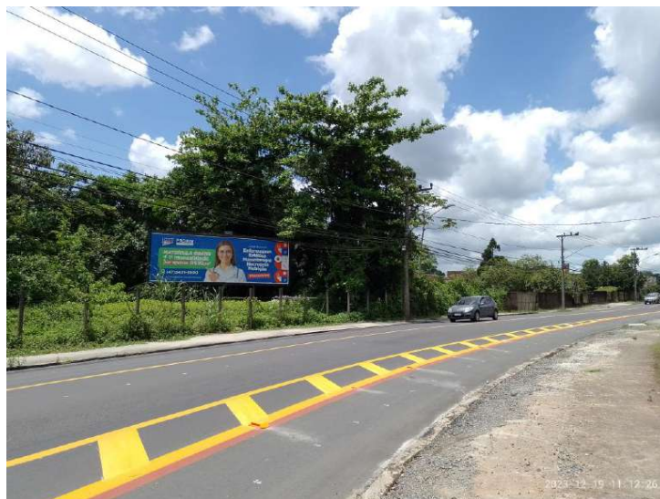
Figura 46: Sinalização horizontal de ciclofaixa e divisão dos sentidos da pista em frente ao imóvel em estudo.
