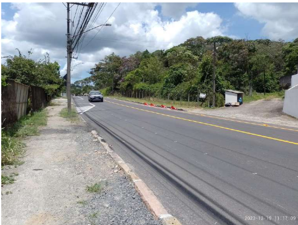
Figura 24: Postes de iluminação pública na rua Copacabana, sentido rua Olaria.
