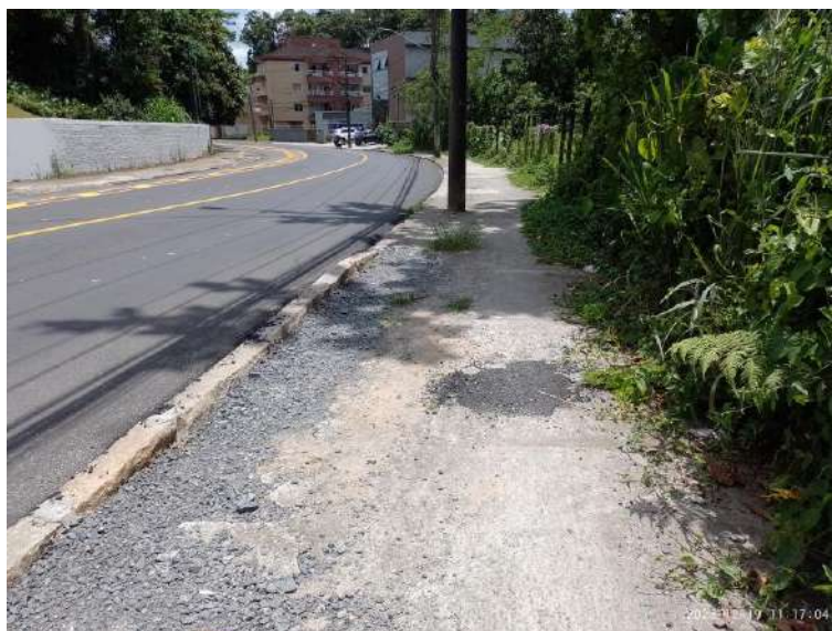
Figura 29: Calçada irregular em frente ao imóvel em estudo.
