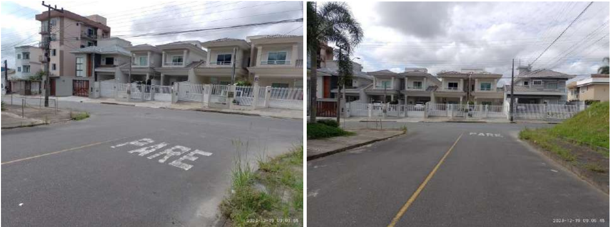
Figura 51: Sinalização horizontal na rua Expedicionário Septimo Faustino Zavaschi, na interseção com a rua Olaria.
