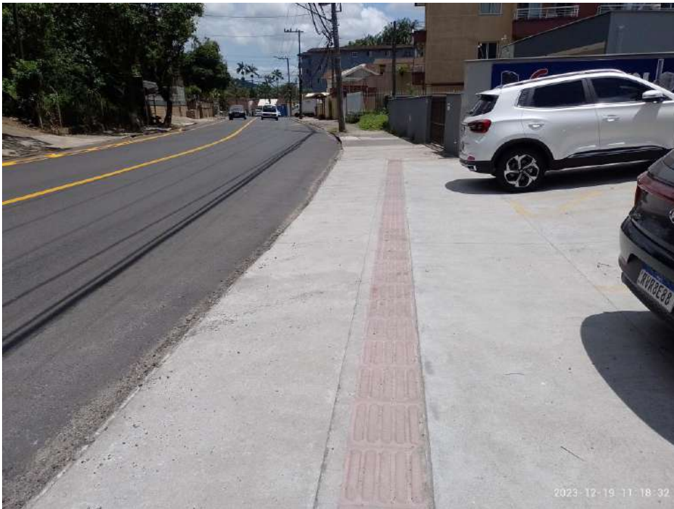
Figura 14: Calçada com acessibilidade na rua Copacabana, vista para rua Farroupilha.
