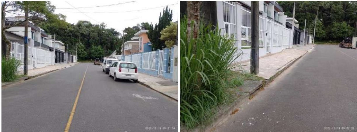
Figura 21: Boca de lobo na rua Expedicionário Séptimo Faustino Zavaschi.
