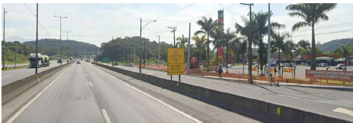
Figura: Sinalização vertical de advertência. Fonte: Google Street View, 2023.
