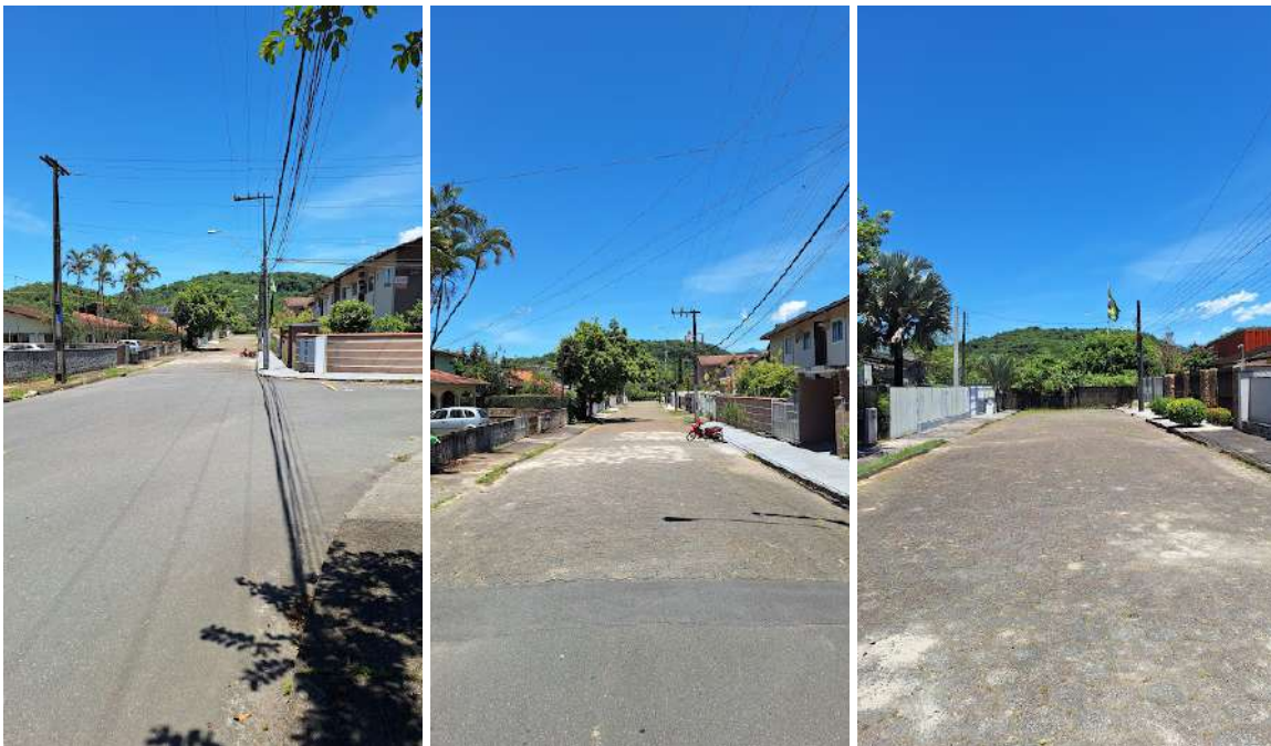
Figura: Registros fotográficos da pavimentação da Angelo Storrer. Fonte: M.URB, 2023.
