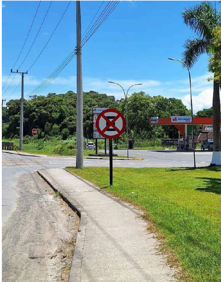
Figura 14 – Sinalização vertical de advertência e de regulamentação
