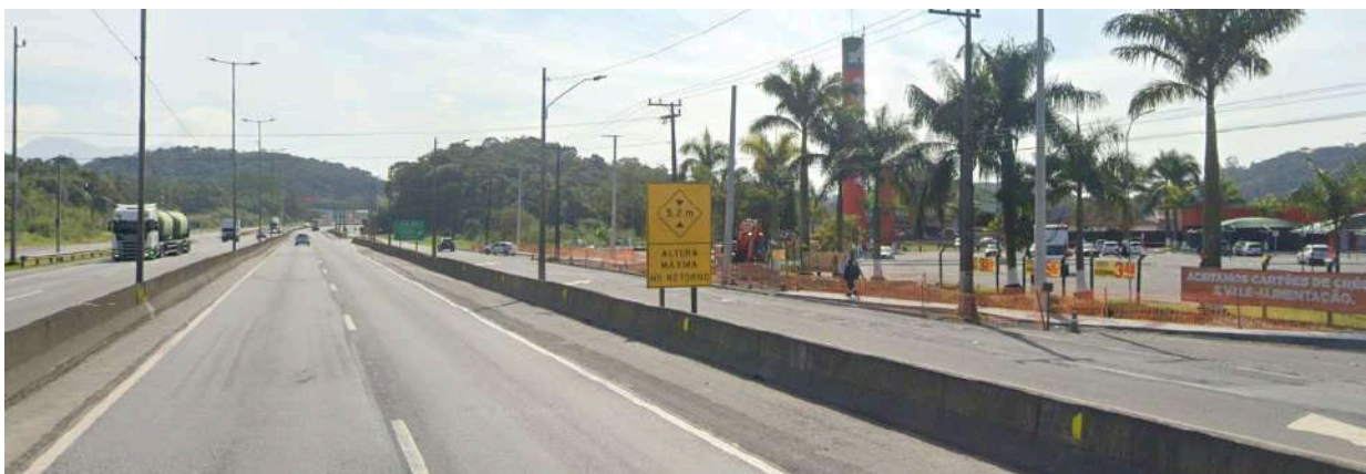
Figura 13 – Sinalização vertical de advertência
