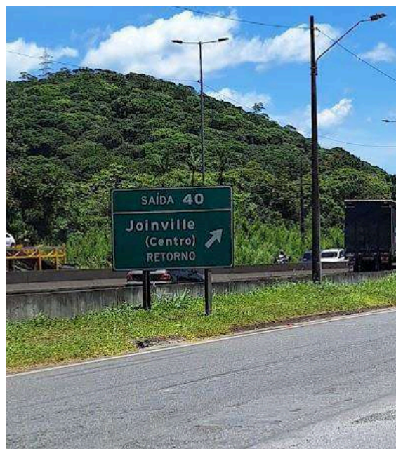
Figura: Sinalização vertical de indicação. Fonte: M.URB, 2023..
