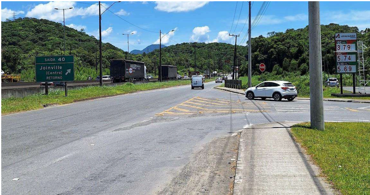
Figura 12 – Condição da sinalização horizontal
