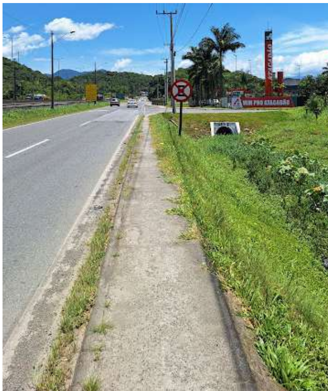
Figura: Calçadas com largura útil reduzida por vegetação. Fonte: M.URB, 2023.
