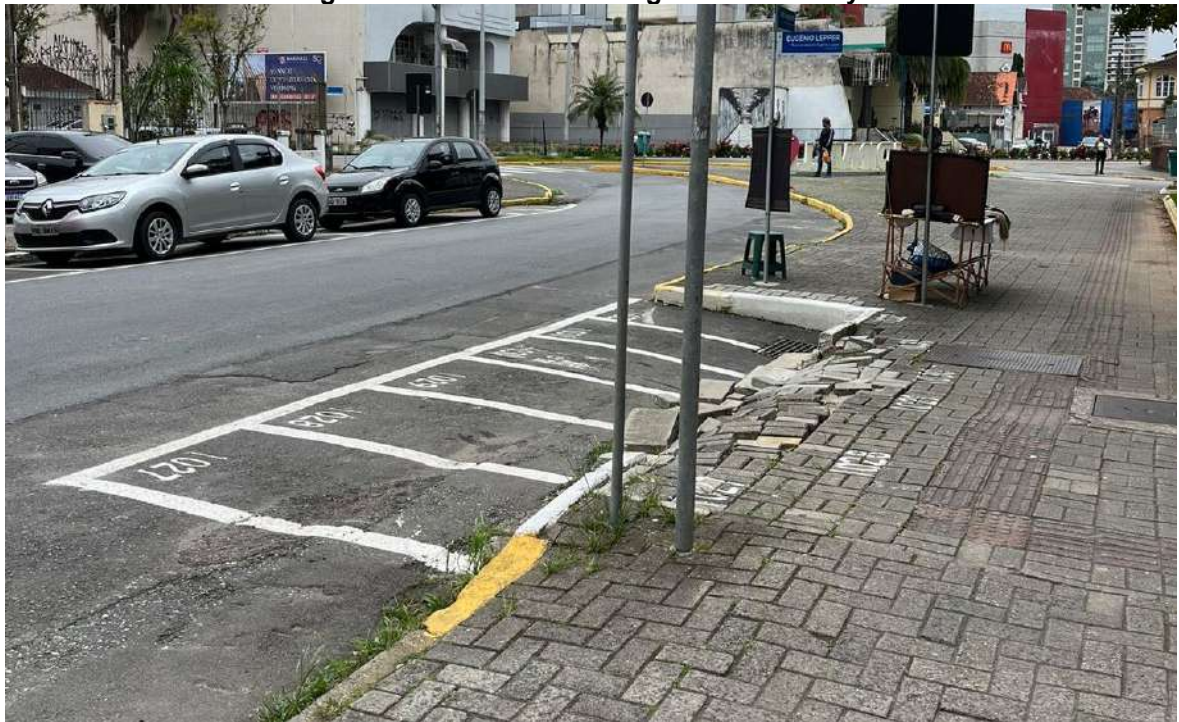
Figura 33 – Vista da Rua Engenheiro Niemeyer
