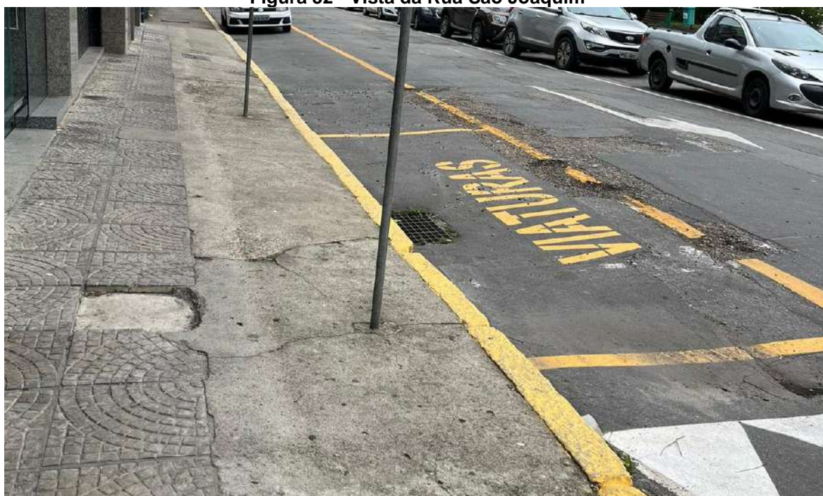
Figura 32 - Vista da Rua São Joaquim
