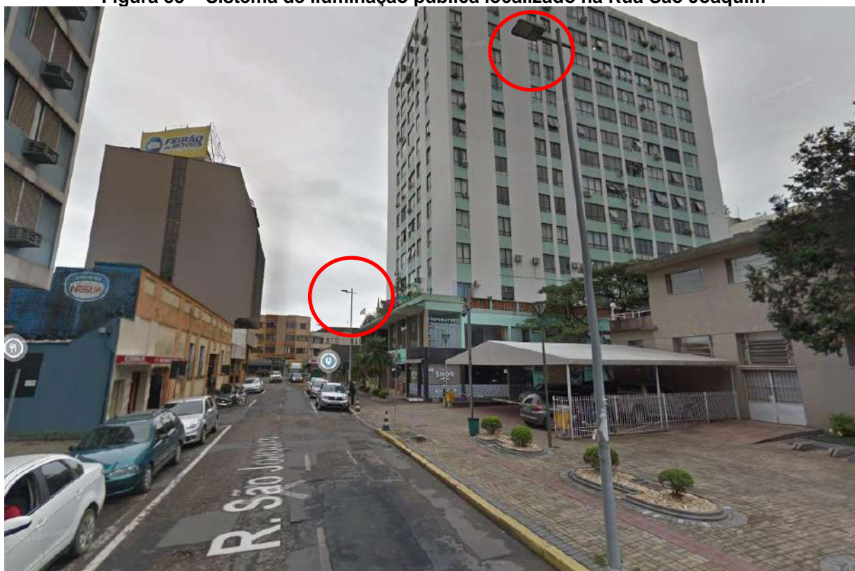
Figura 35 – Sistema de iluminação pública localizado na Rua São Joaquim
