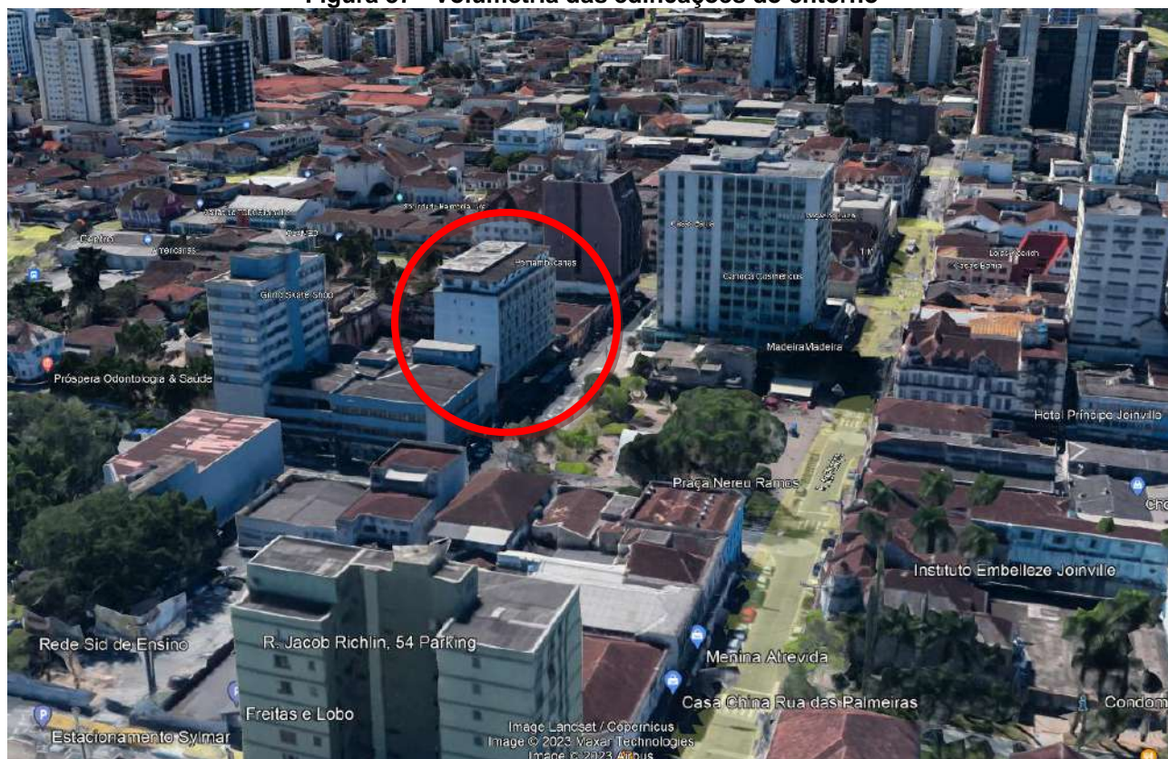
Figura 37 - Volumetria das edificações do entorno
