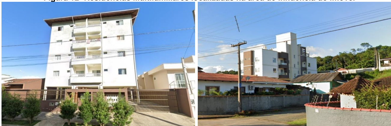
Figura 12- Residências Multifamiliares localizadas na área de influência do imóvel
