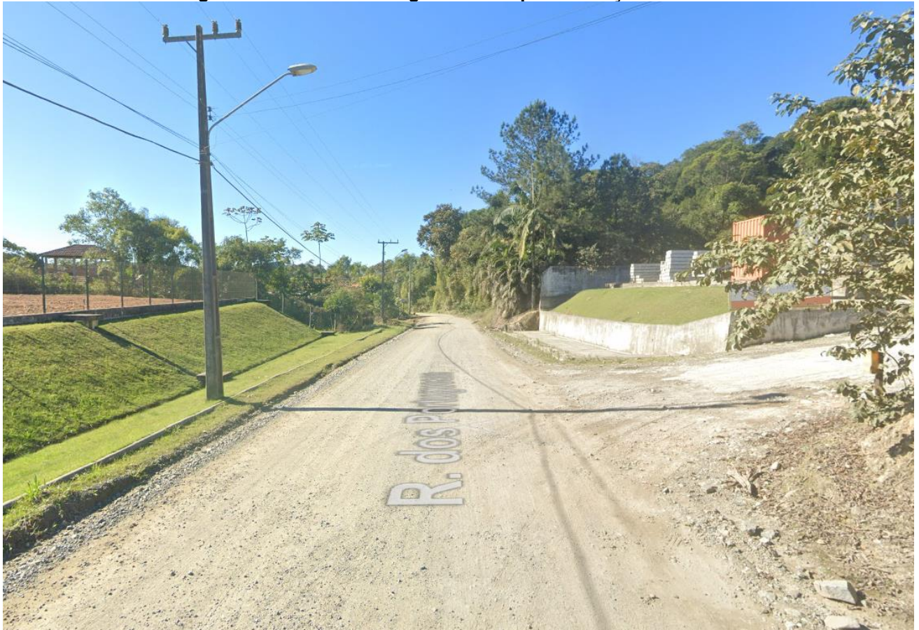
Figura 42 - Rua dos Portugueses sem pavimentação asfáltica
