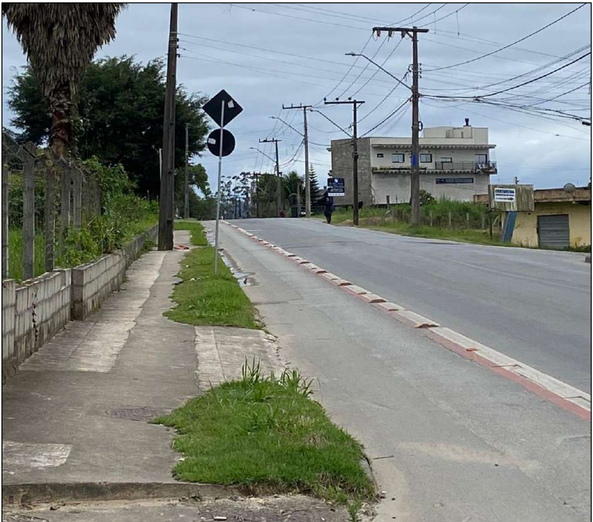
Figura 41. Rua pavimentada de acesso ao empreendimento. Autor: DBio, 2023.
