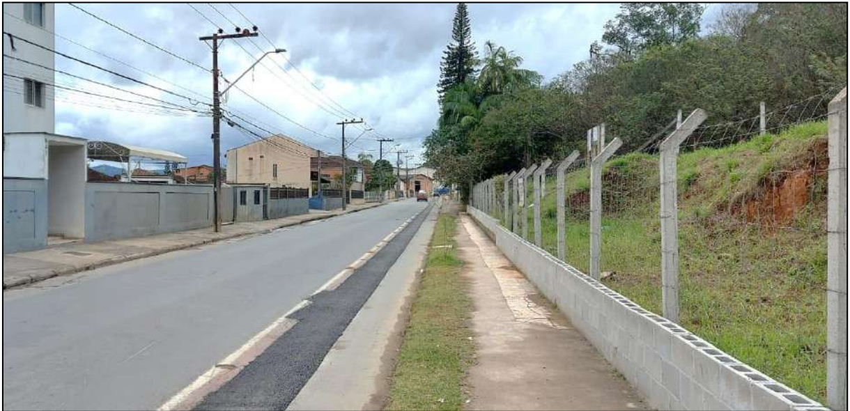
Figura 39: Rua pavimentada de acesso ao empreendimento. Autor: DBio, 2023.
