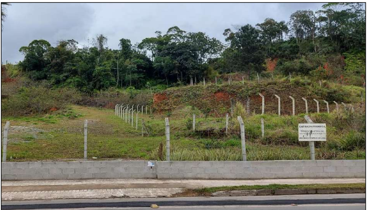
Figura 24: PRAD executado na área do empreendimento. Autor: DBio, 2021.
