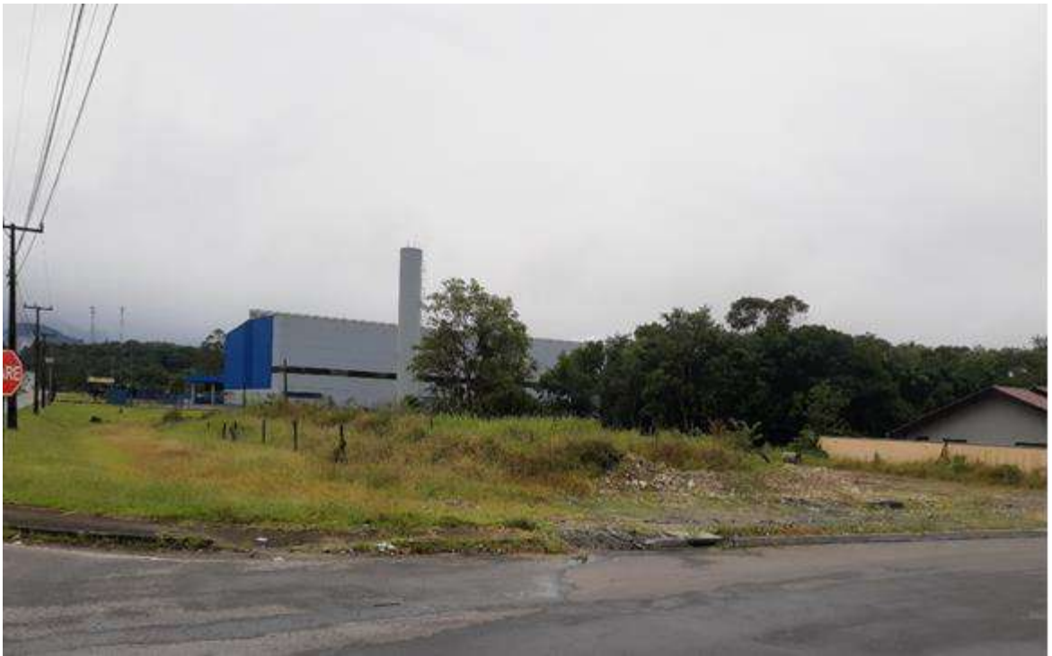
Figura 28: Imagem atual do imóvel.
