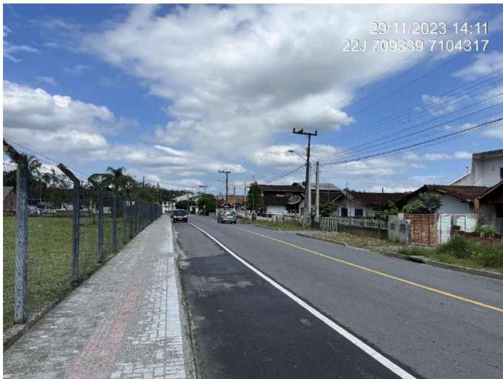
Figura 24: Iluminação pública ao longo da Bernardo Schneider.
