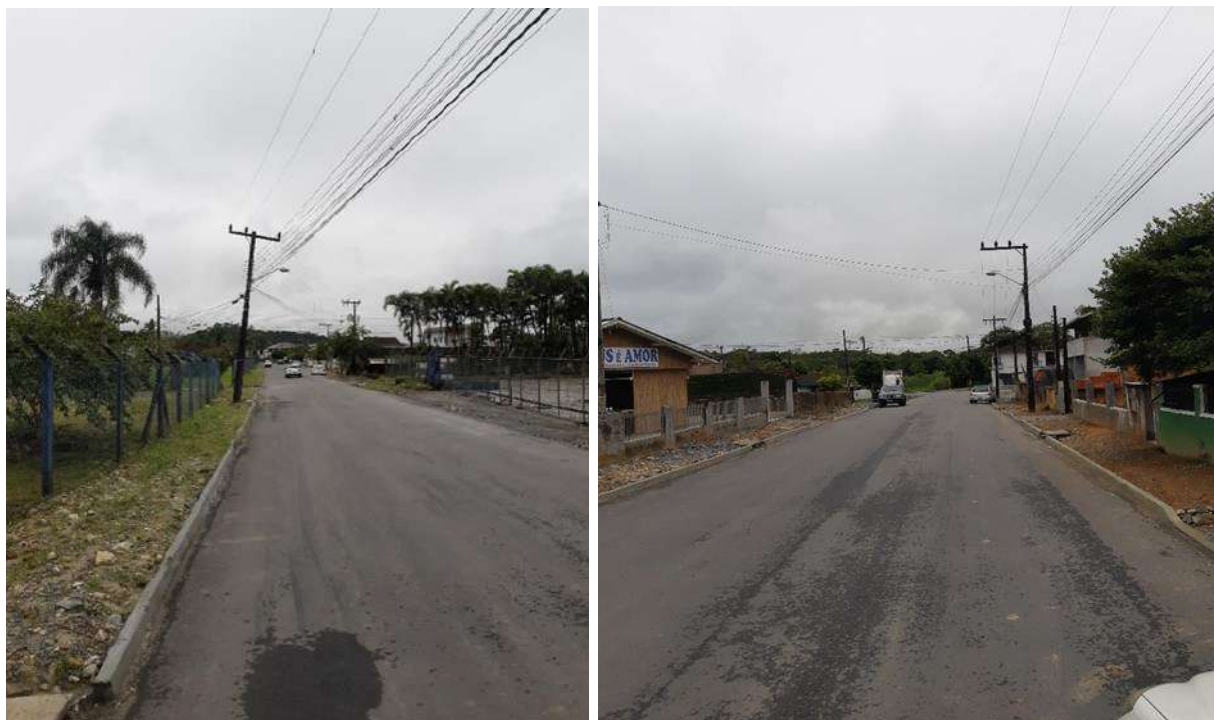
Figura 7: Rua asfaltada com infraestrutura aplicada e predominância residencial (esq.) e edificações institucionais (igreja) próximo ao imóvel (dir.).
