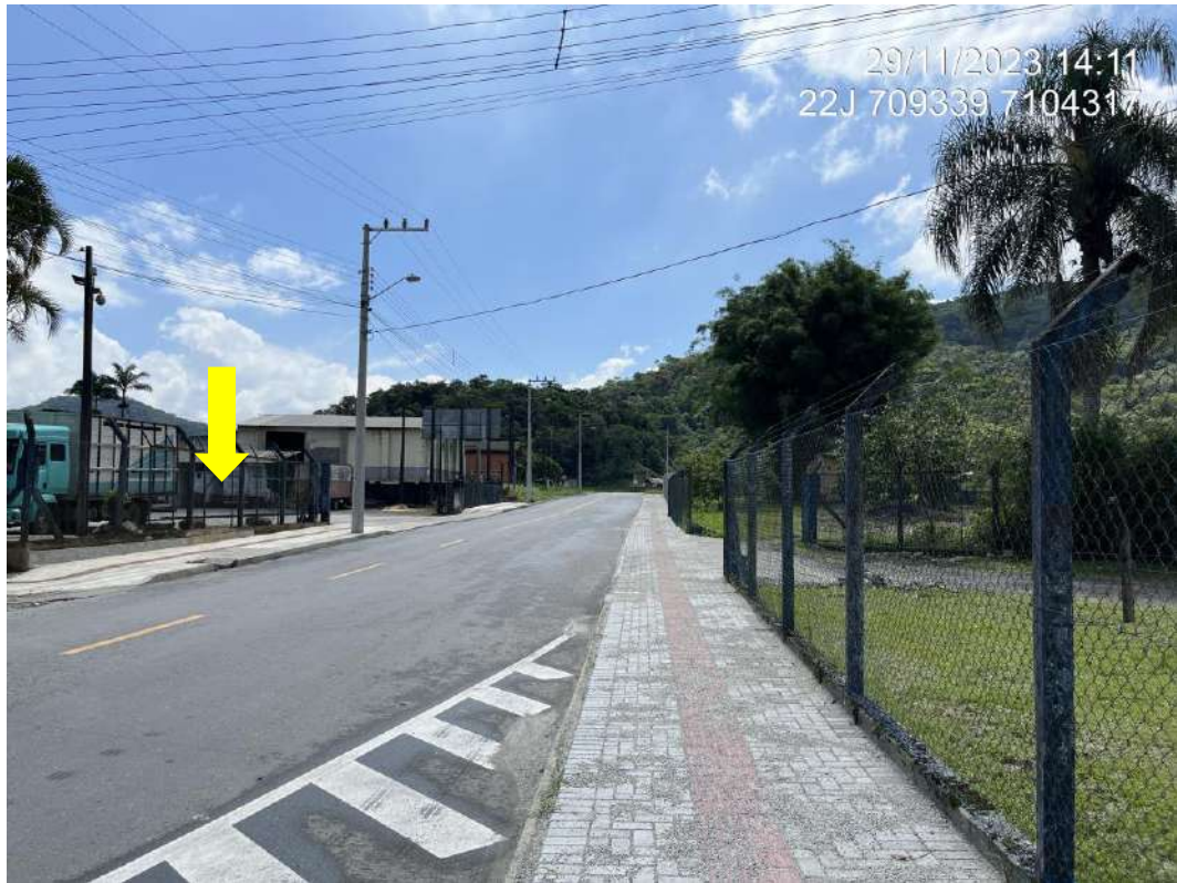
Figura 17: Calçadas pavimentada na rua Bernardo Schneider, trecho em frente a imóveis comerciais.
