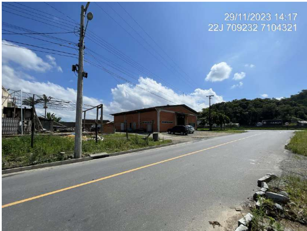
Figura 18: Calçadas sem pavimentação, trecho final da Bernardo Schneider.
