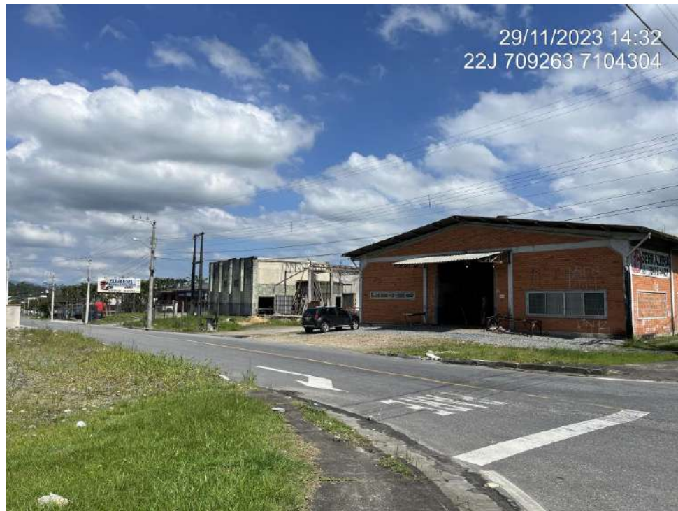
Figura 34: Via em frente ao imóvel em estudo, onde não há calçada instalada.
