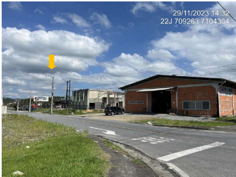
Figura 25: Iluminação na rua Bernardo Schneider, esquina com faixa marginal da rodovia.
