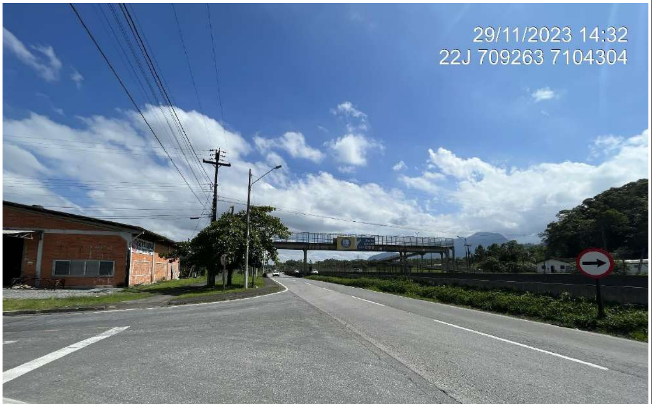
Figura 40: Passarela de pedestres sob rodovia Governador Mario Covas.
