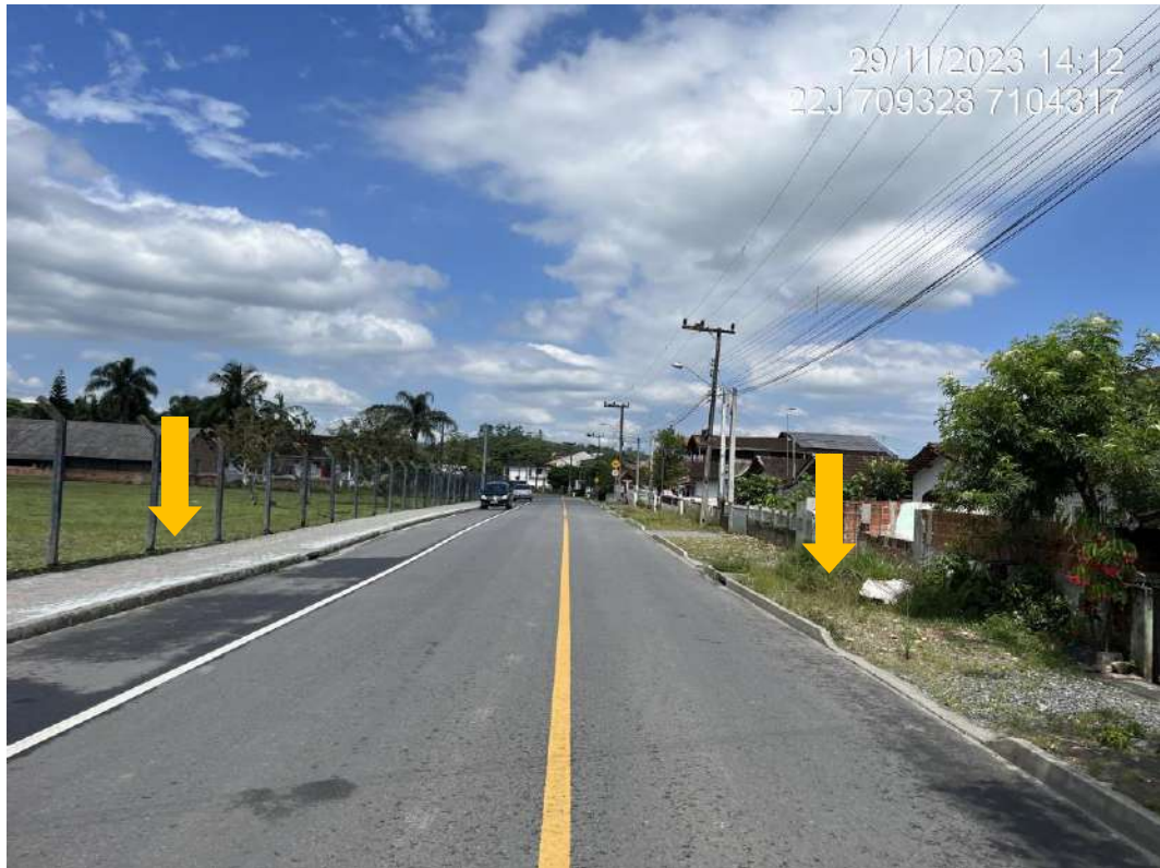
Figura 16: Aspecto das calçadas na rua Bernardo Schneider (vista para 15 de outubro), trecho em frente a imóvel comercial, com blocos, e residências, sem pavimentação.
