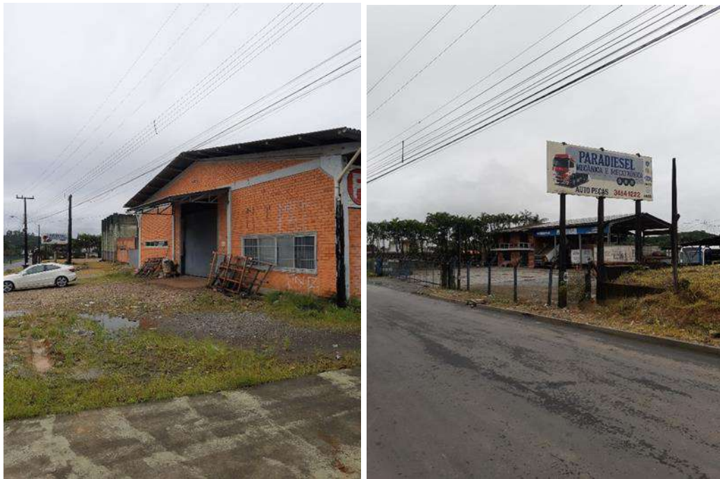
Figura 5: Galpão de Serviços/Comércio desativado (esq.) e Mecânica de Caminhões (dir.) na rua Bernardo Schneider.
