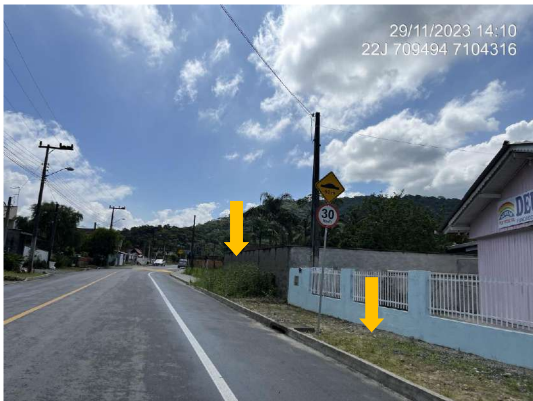
Figura 15: Aspecto da calçada no início da rua Bernardo Schneider, lado direito no sentido rodovia.
