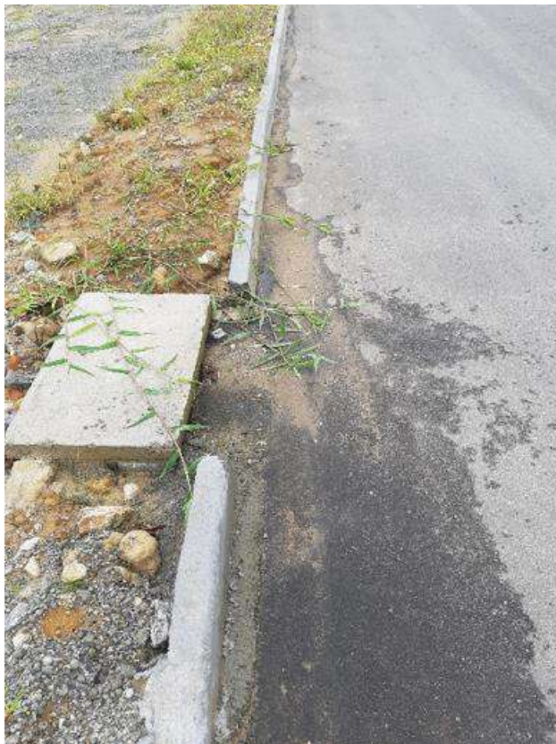
Figura 22: Captação de Drenagem Pluvial, rua Bernardo Schneider.
