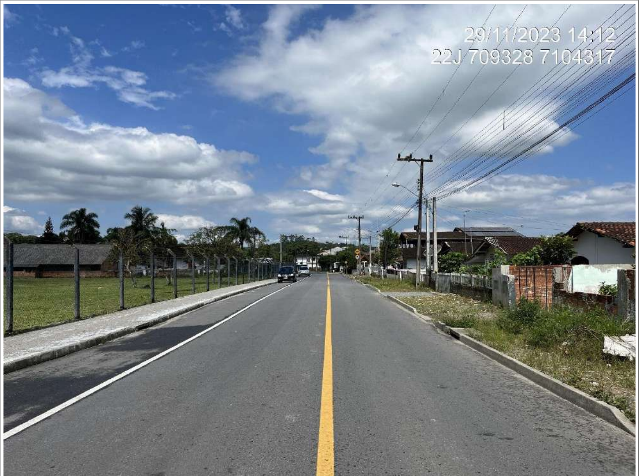
Figura 39: Rua Bernardo Schneider (vista para rua 15 de outubro), sem ciclovia.
