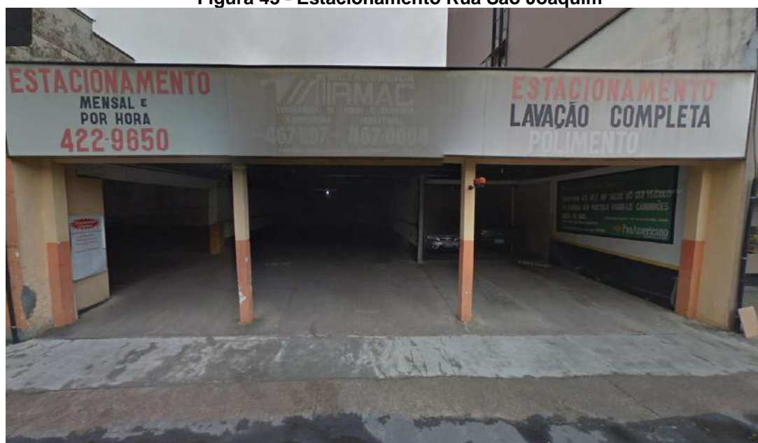
Figura 43 - Estacionamento Rua São Joaquim
