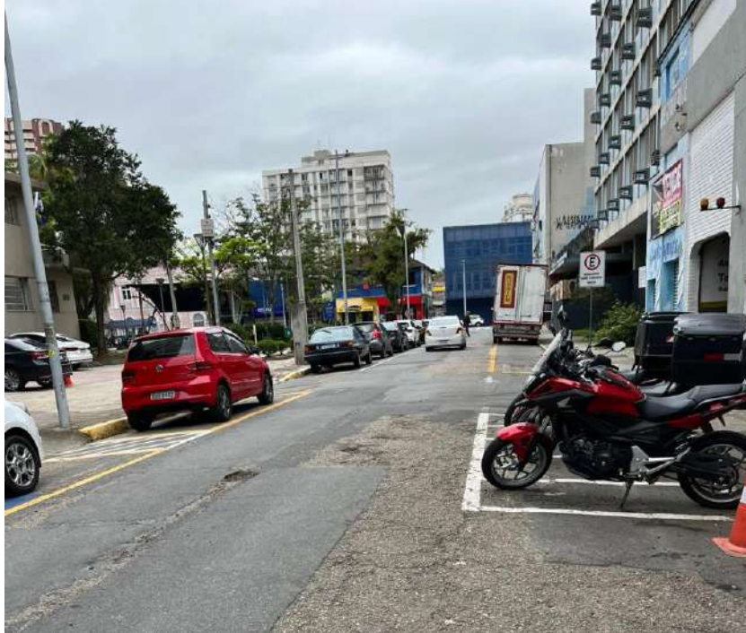
Figura 29 - Rede de abastecimento de energia elétrica subterrânea.
