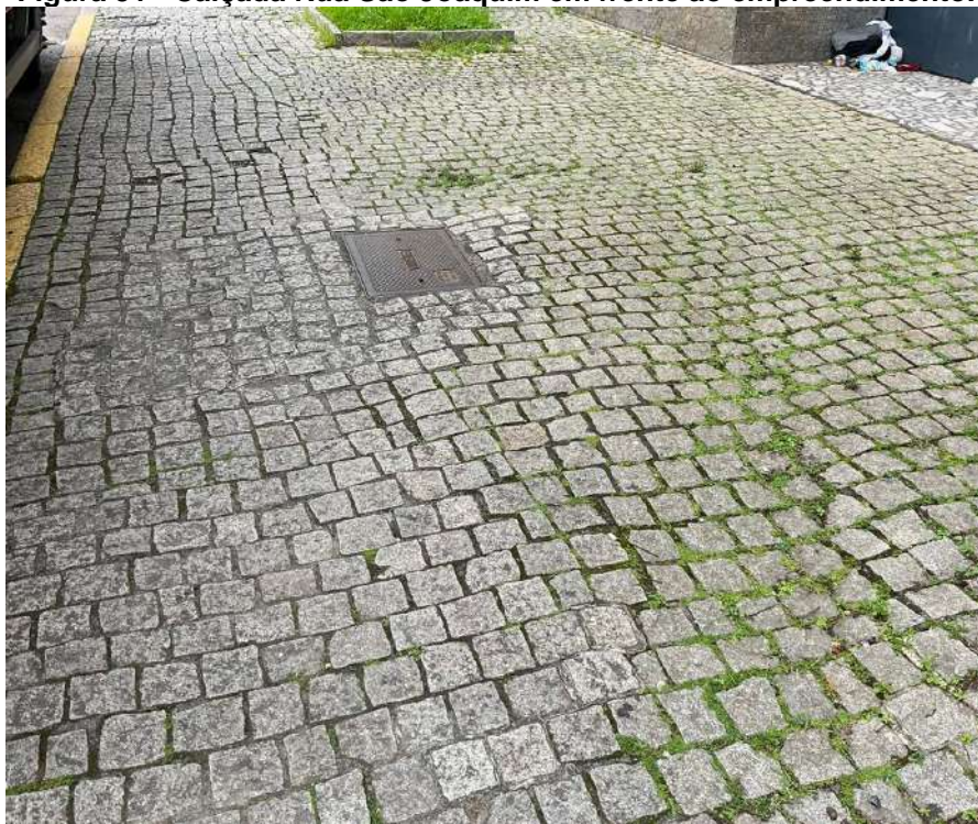
Figura 51 - Calçada Rua São Joaquim em frente ao empreendimento.
