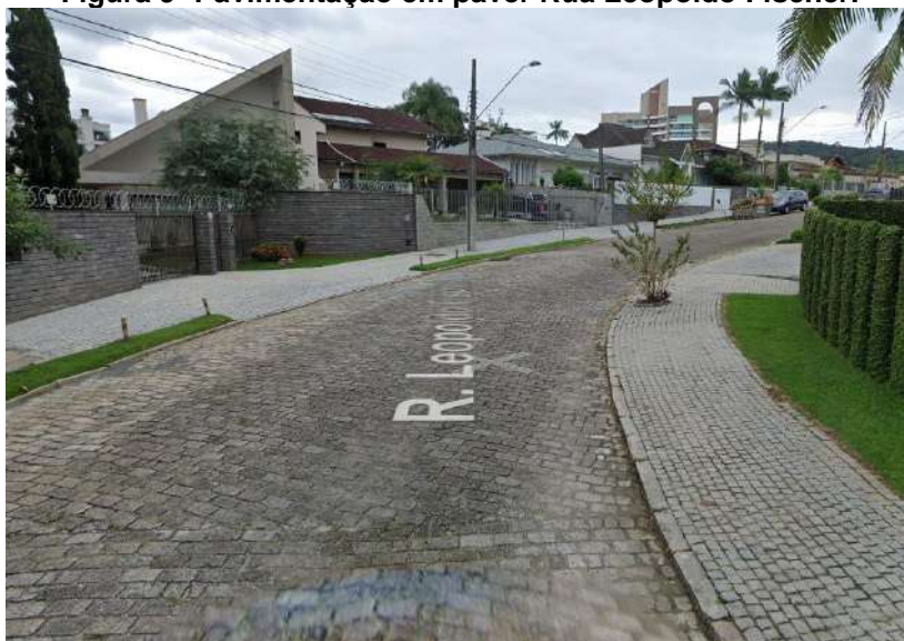
Figura 9- Pavimentação em paver Rua Leopoldo Fischer.
