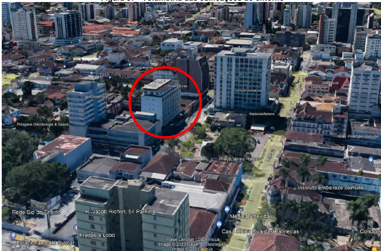
Figura 37 - Volumetria das edificações do entorno
