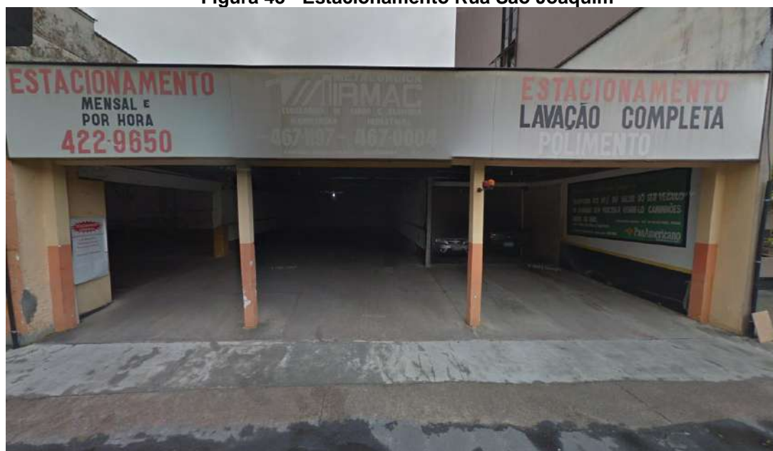
Figura 43 - Estacionamento Rua São Joaquim
