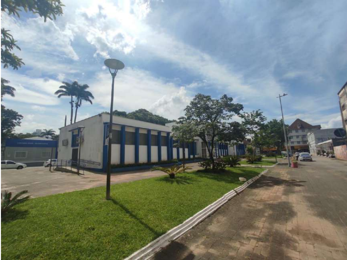
Figura 53- Local a ser instalado piso tátil, extensão de 50 metros defronte a Biblioteca Municipal
