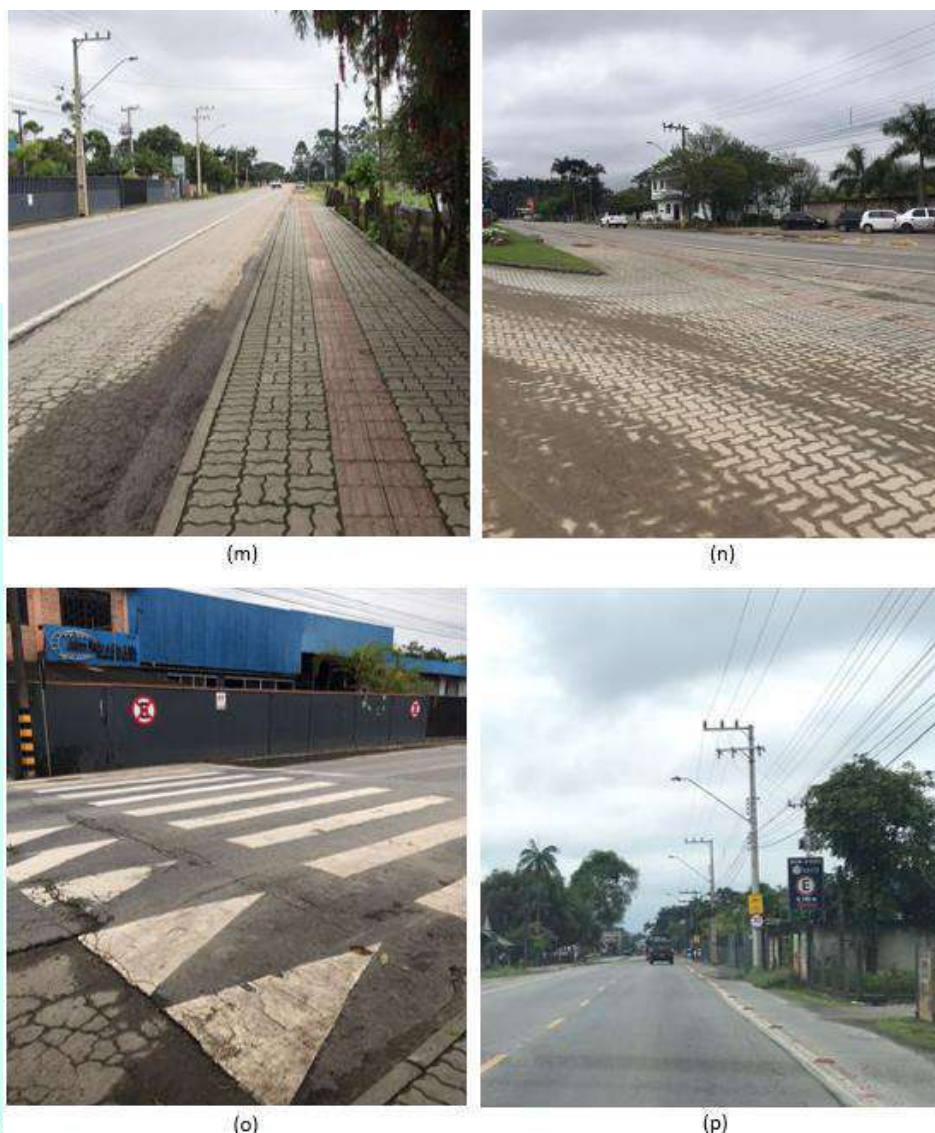
Figura 56 – (m) e (n) Passeio com piso tátil no lado direito, (o) Faixa elevada para travessia de pedestres em frente ao empreendimento e (p) Ciclofaixa no lado esquerdo;
