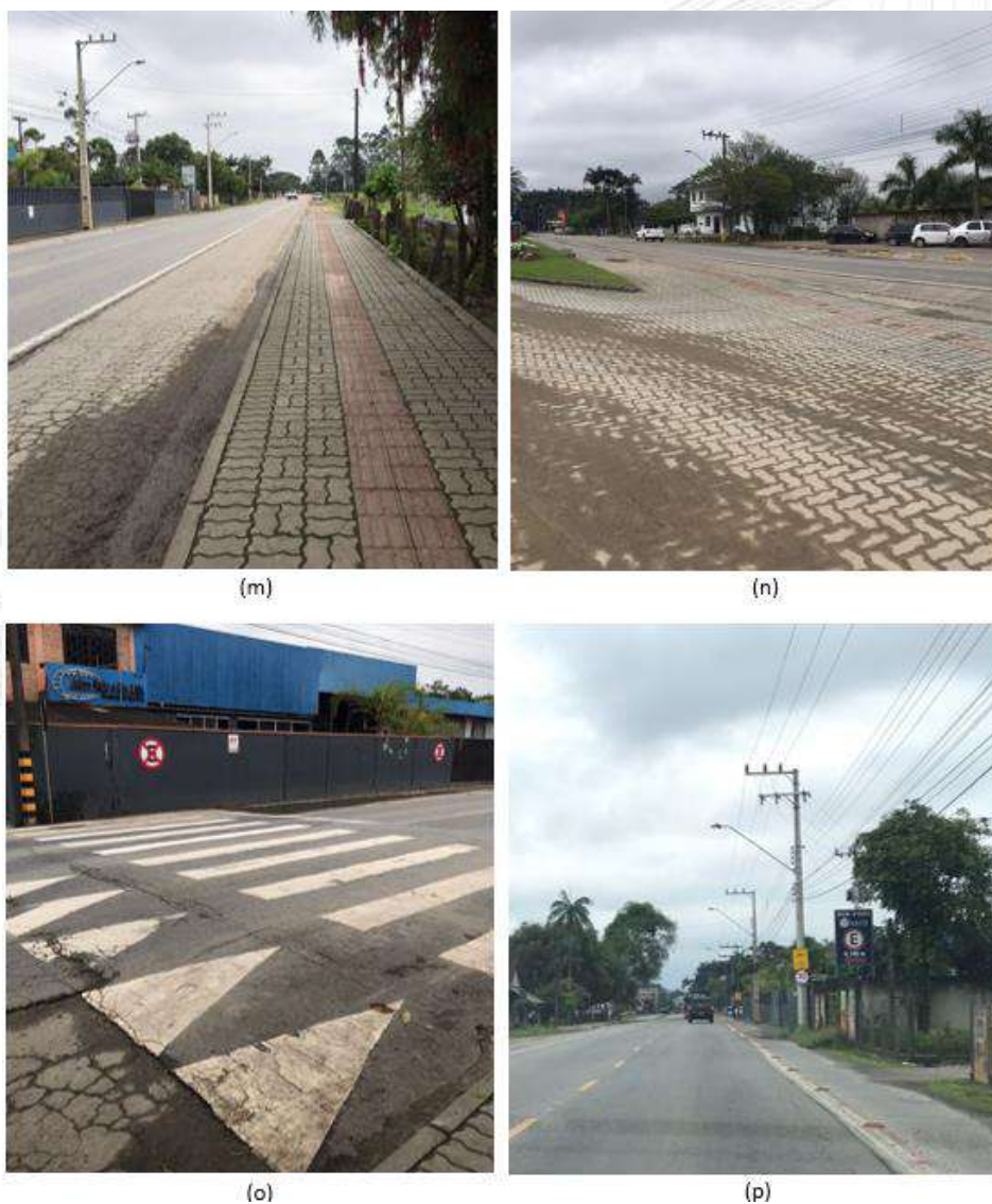
Figura 79 – (m) e (n) Passeio com piso tátil no lado direito, (o) Faixa elevada para travessia de pedestres em frente ao empreendimento e (p) Ciclofaixa no lado esquerdo;
