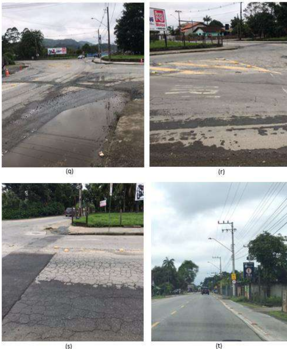
Figura 57 – (q), (r) e (s) Sinalização Horizontal da Rotatória e (t) Ciclofaixa, pintura da faixa de rolamento e sinalização vertical da Estrada da Ilha.
