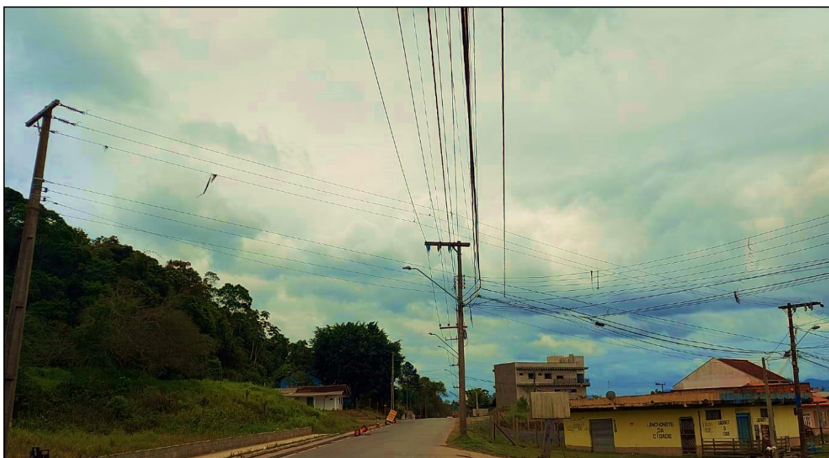
Figura 49: Rede elétrica passando pela área de influência do imóvel em estudo. Autor: DBio, 2021.
