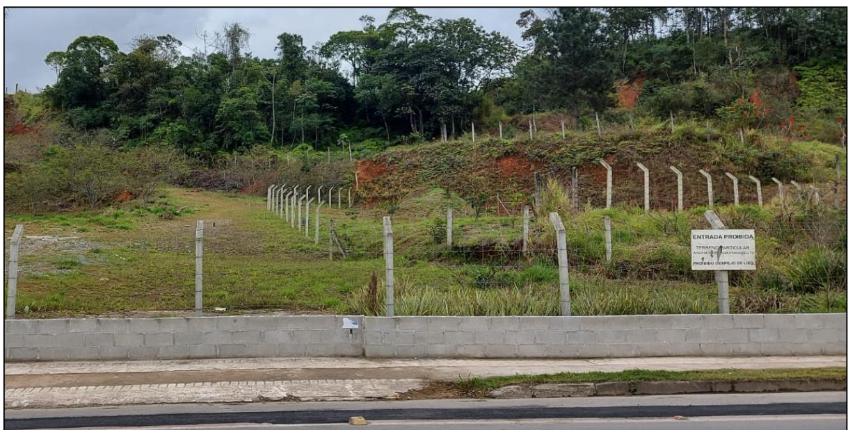
Figura 25: PRAD executado na área do empreendimento. Autor: DBio, 2021.
