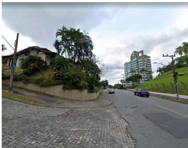
Figura 12- Rede de abastecimento de energia elétrica na Rua Leopoldo Fischer.
