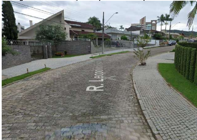
Figura 9- Pavimentação em paver Rua Leopoldo Fischer.
