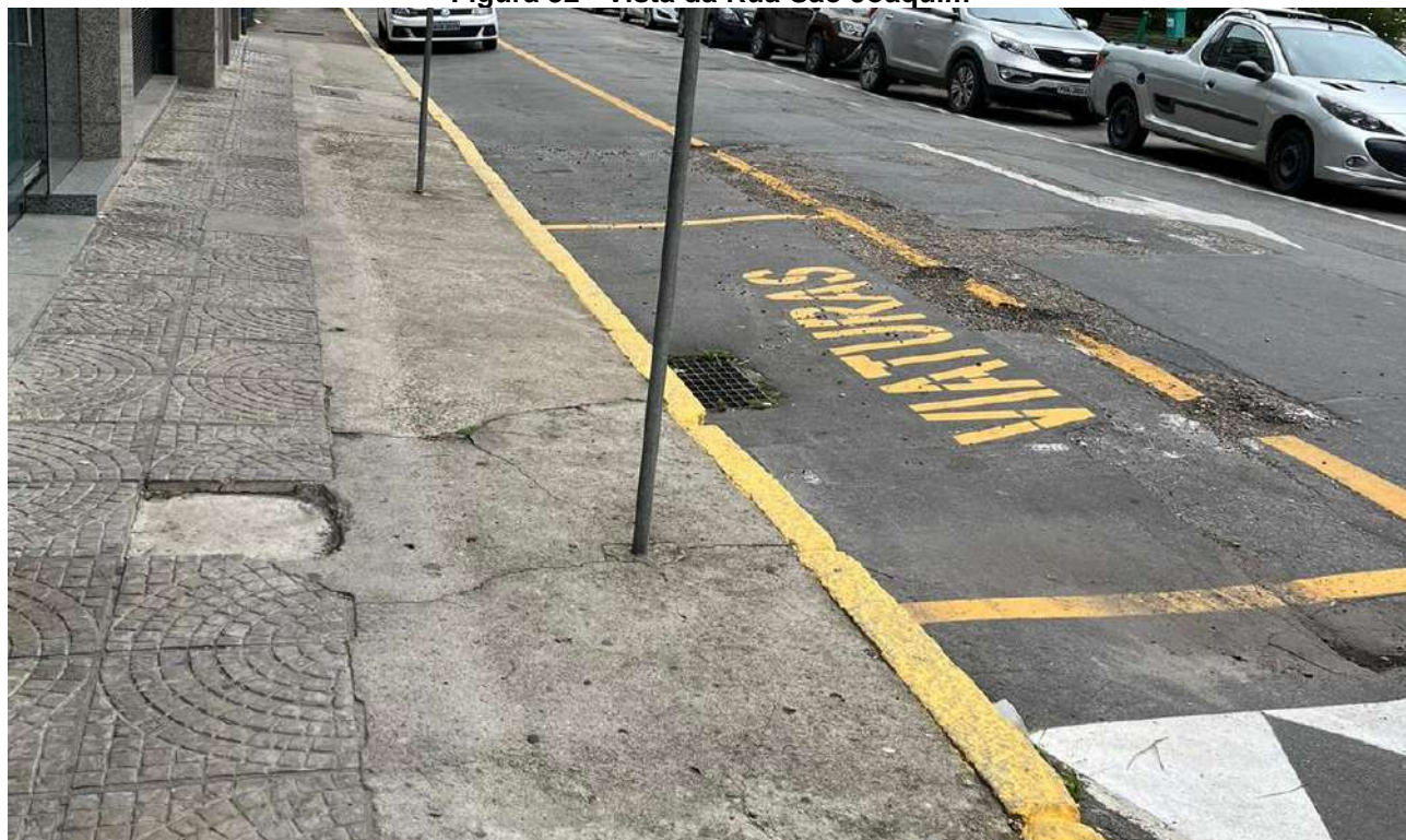
Figura 32 - Vista da Rua São Joaquim
