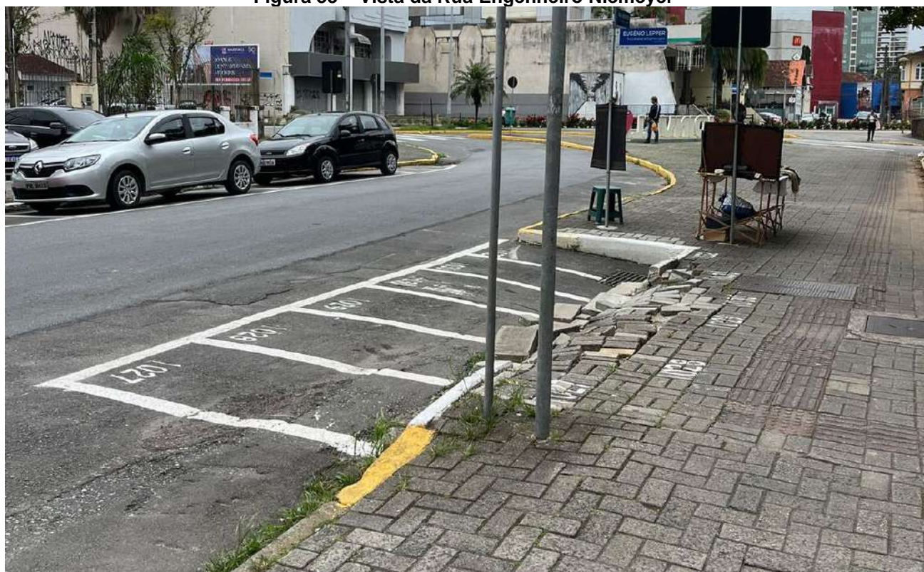
Figura 33 – Vista da Rua Engenheiro Niemeyer
