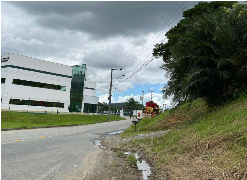
Figura 37- Rede de abastecimento de energia elétrica na Rua dos Portugueses.
