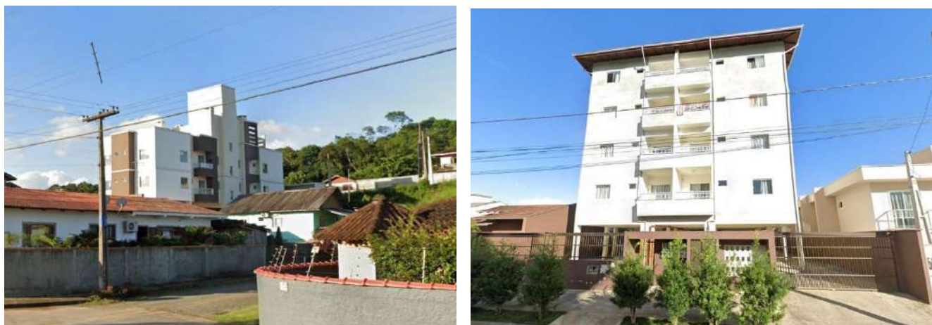
Figura 12- Residências Multifamiliares localizadas na área de influência do imóvel.
