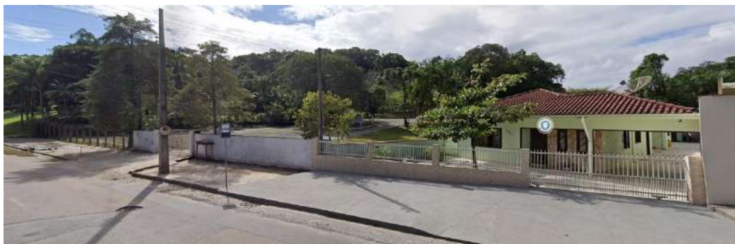
Foto 61 – Edificação vizinha – Rua Santa Catarina – sentido sul-norte.
