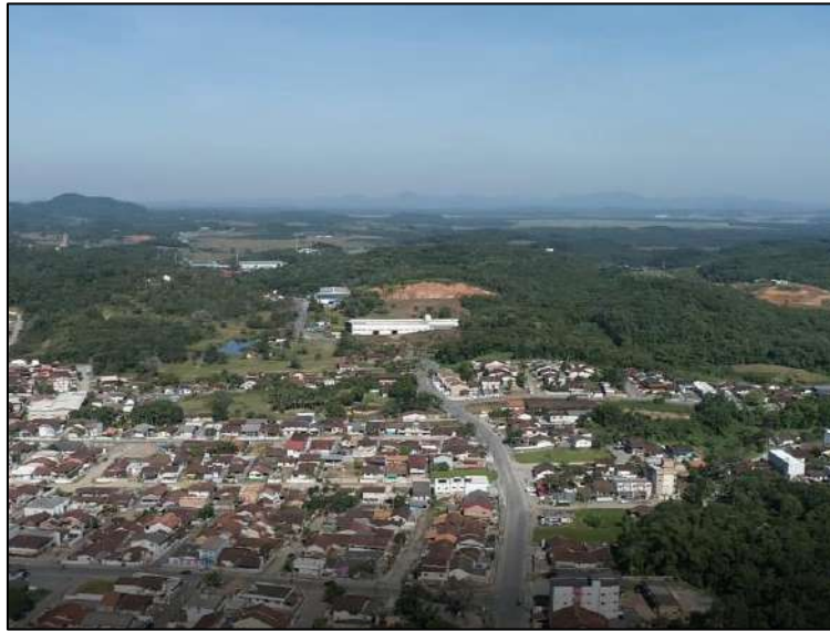
Figura 20. Vista no sentido leste da All, área urbana consolidada.
