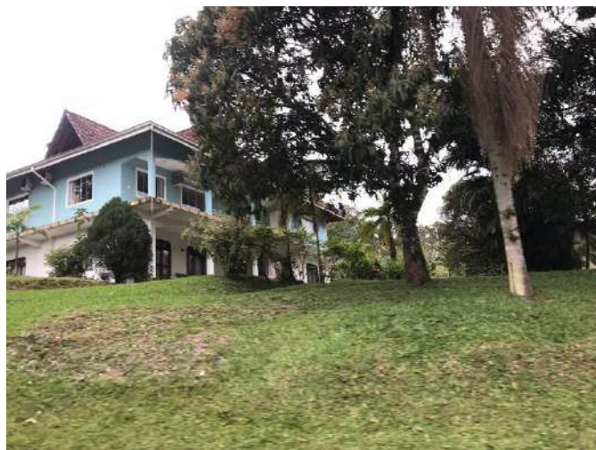
Foto 60 – Edificação vizinha – Rua Santa Catarina – sentido norte-sul.
