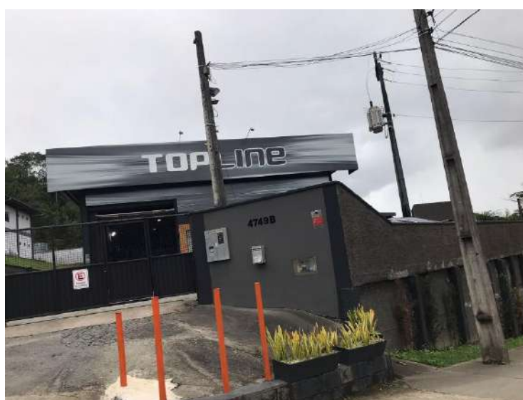
Foto 62 – Serviço próximo ao futuro empreendimento.
