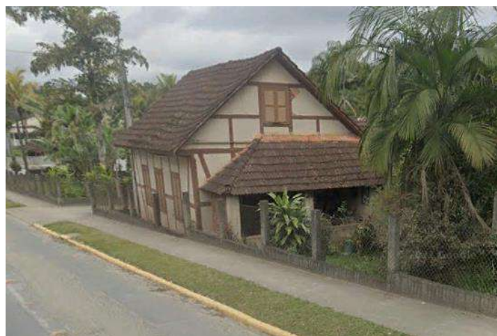
Figura 46: Imóvel em processo de tombamento Rua Santa Catarina
