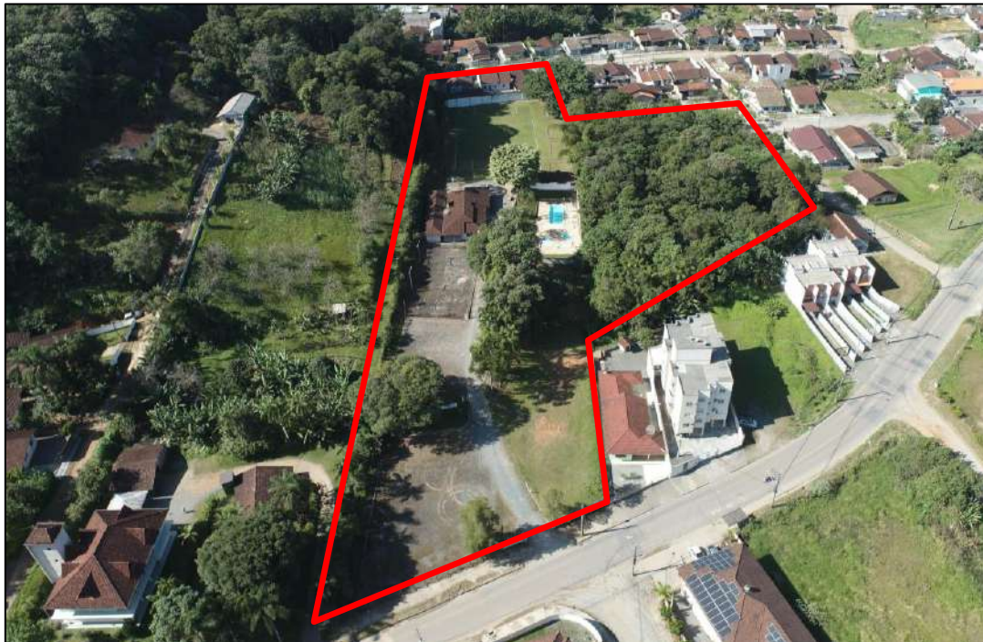
Figura 11: Aerofotografia com vista da ADA e entorno próximo (AID) sentido oeste.
