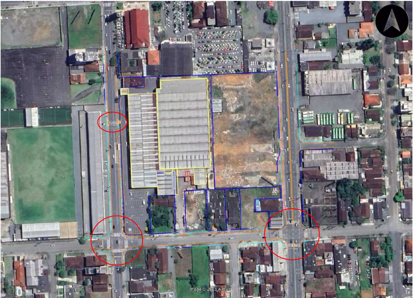
Figura 4.10 - Travessias de pedestres próximas ao empreendimento. Fonte: Google Earth.
