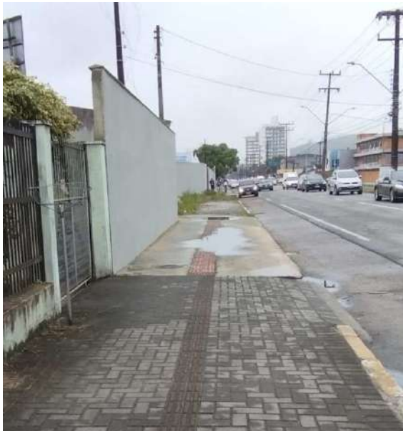
Calçada com piso tátil direcional.
