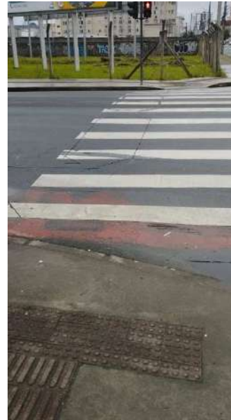
Piso tátil direcional e calçada rebaixada para travessia de pedestres
