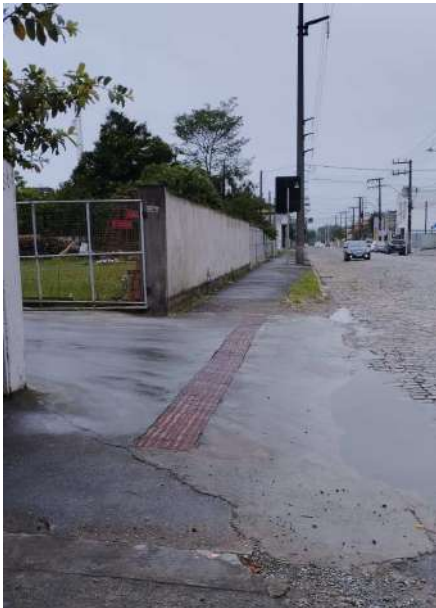
Saída de caminhões com piso tátil direcional para pedestres na calçada
