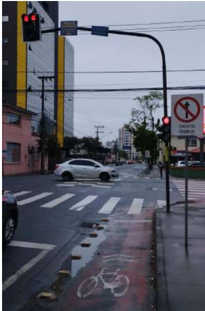
Pavimentação, sinalização de qualidade e preservada. Rebaixo para ciclofaixa
