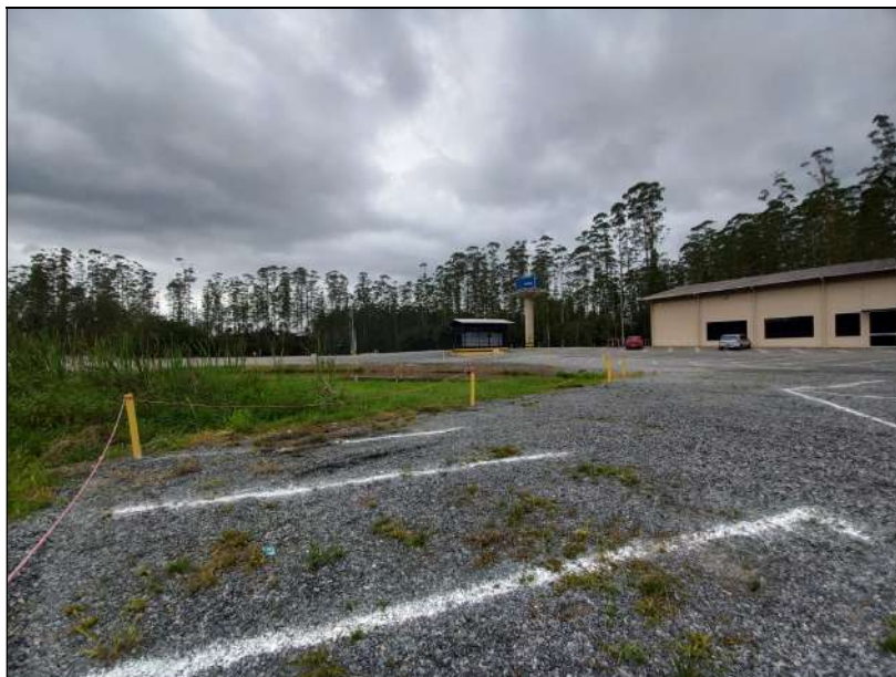
Figura 08: Visão geral da área que será aterrada – Fonte: O autor (2022).
