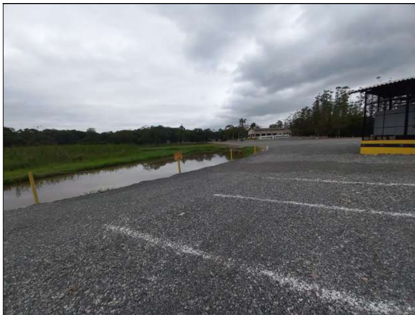
Figura 12: ponto de acumulação de água que será aterrado - Fonte: O autor (2022).
