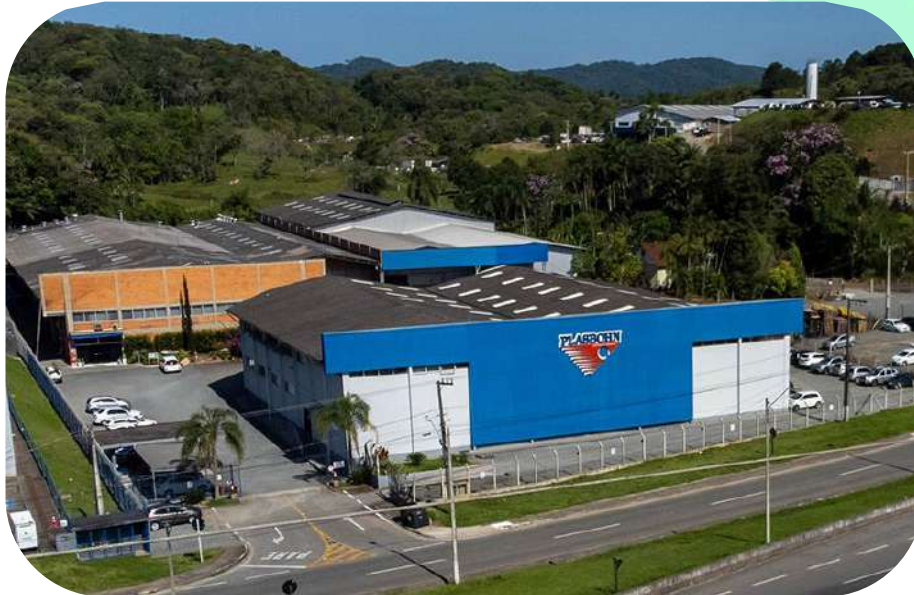
Figura 7: Imagem da instalação atual da Plasbohn.
