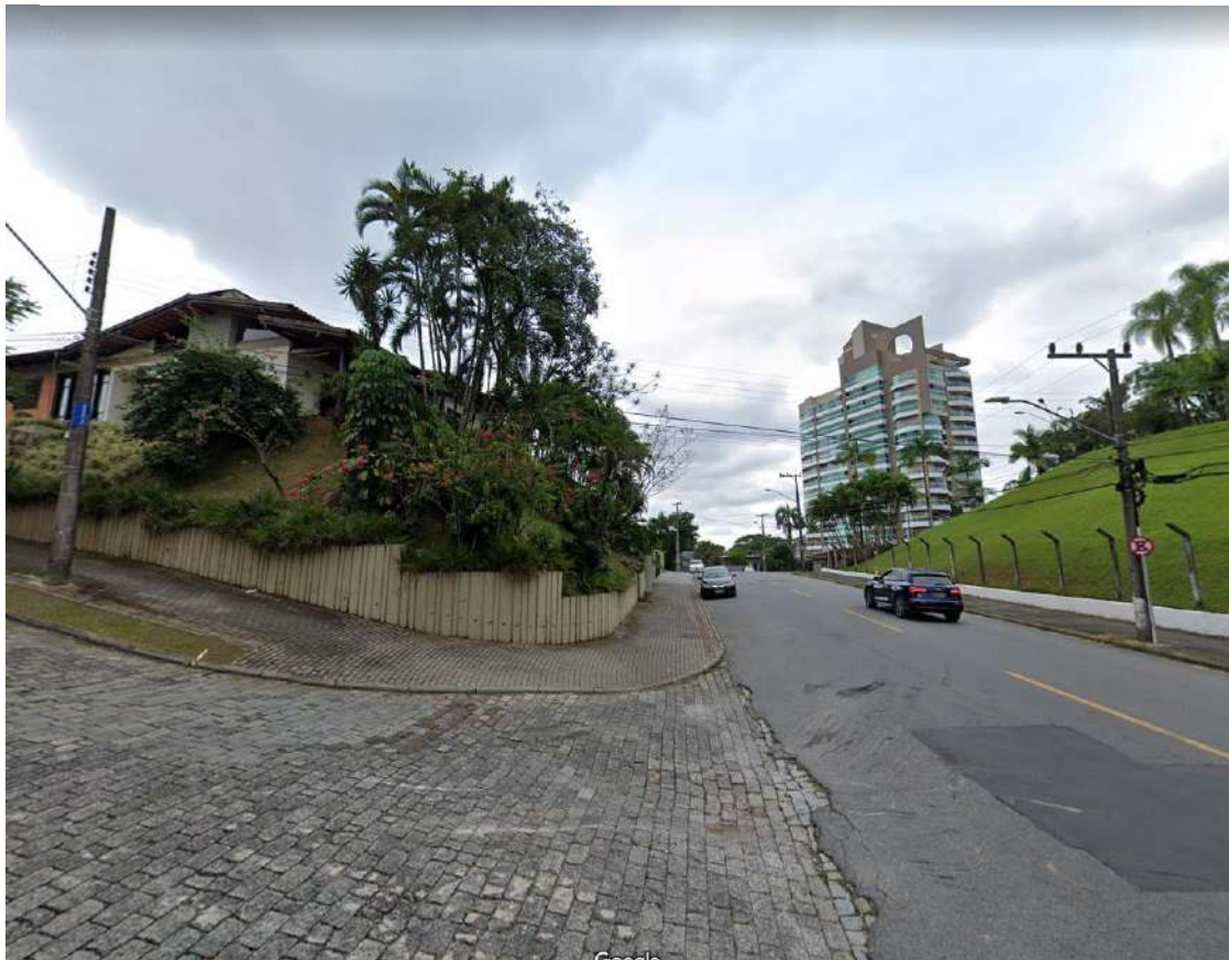
Figura 39- Rede de abastecimento de energia elétrica na Rua Leopoldo Fischer.
