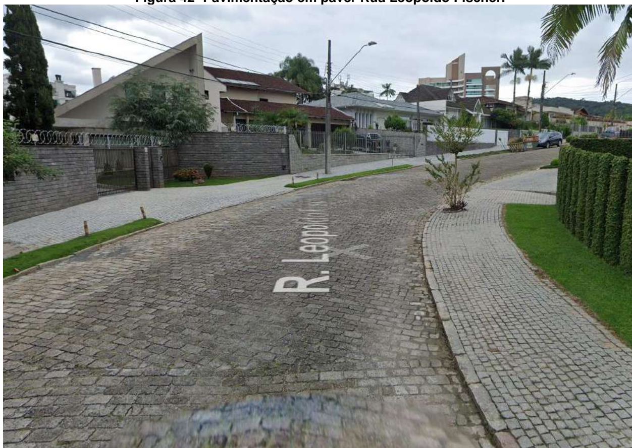
Figura 42- Pavimentação em paver Rua Leopoldo Fischer.
