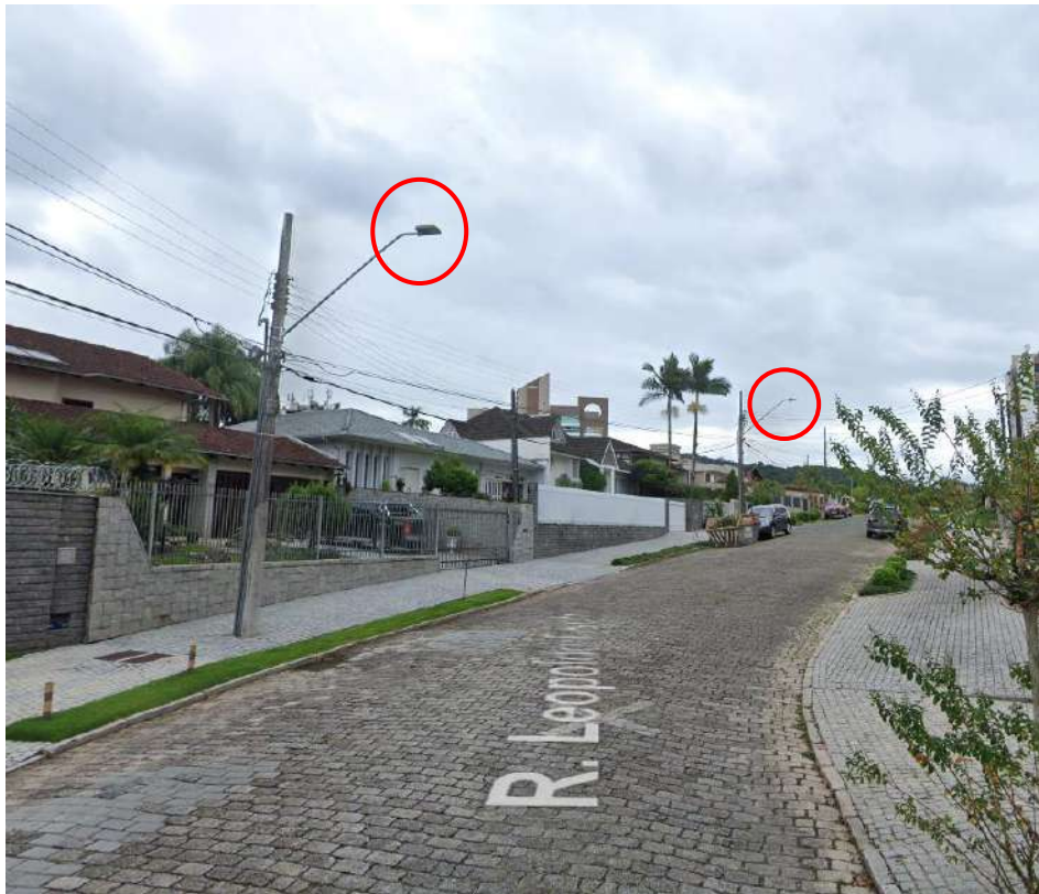
Figura 43- Sistema de iluminação pública localizada na Rua Leopoldo Fischer.
