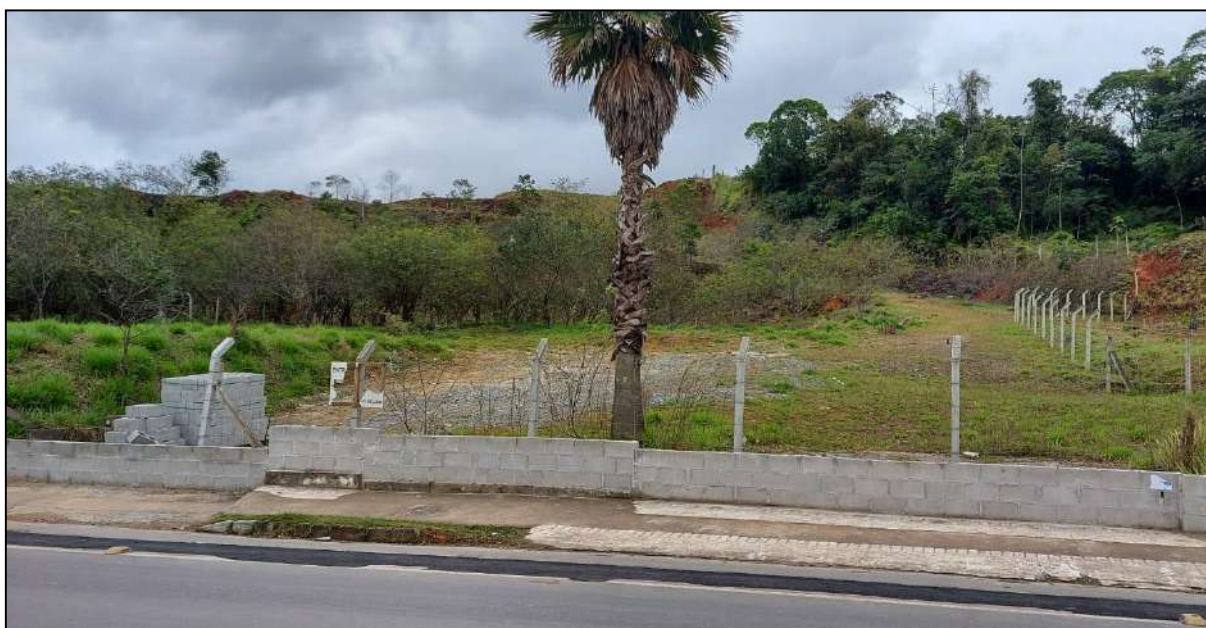
Figura 7: Vista frontal do empreendimento em estudo. Autor: DBio, 2021.
