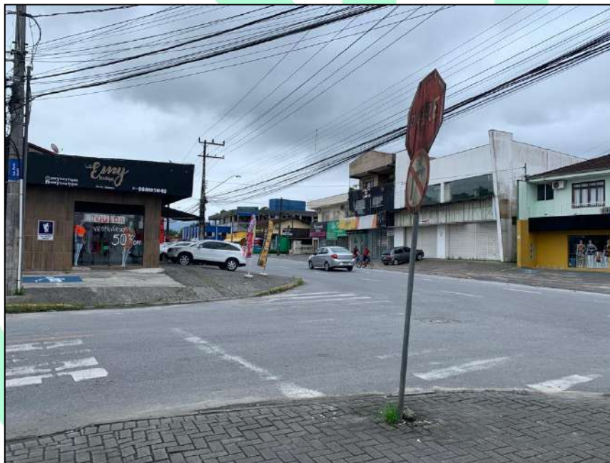
Figura 70: Interseção Rua XV de Novembro x Rua Dante Nazato, visada para oeste.
