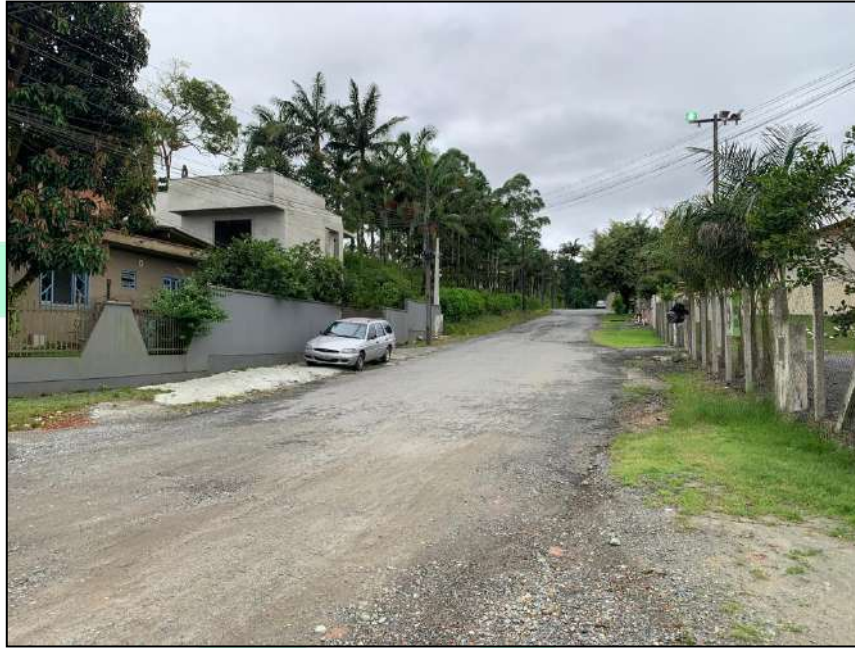
Figura 87: Rua Alberto Miers, visada para leste.
