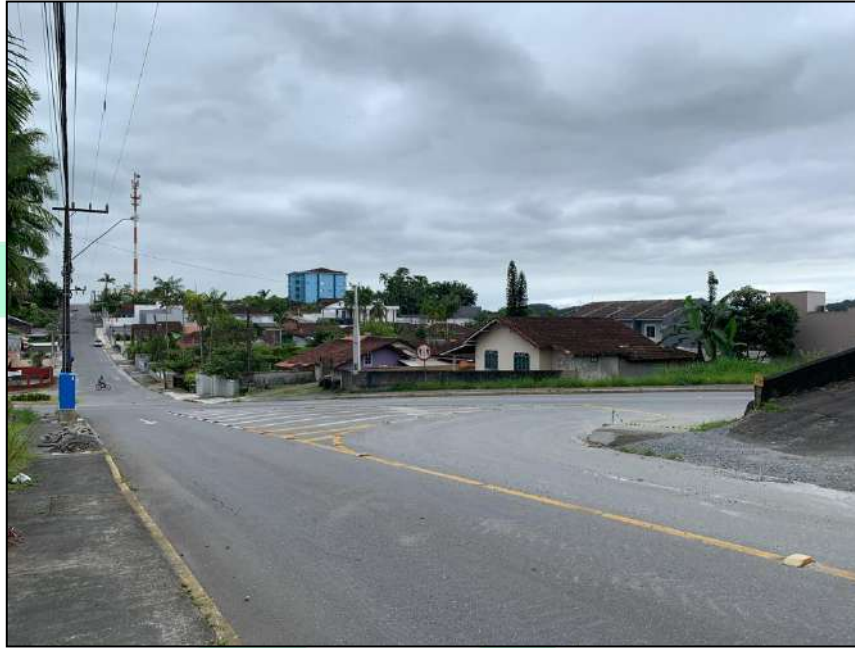
Figura 75: Interseção Rua São Firmino x Rua Leopoldo Beninca x Rua Dante Nazato, destaque para Rua Leopoldo Beninca e Rua Dante Nazato, visada para norte.
