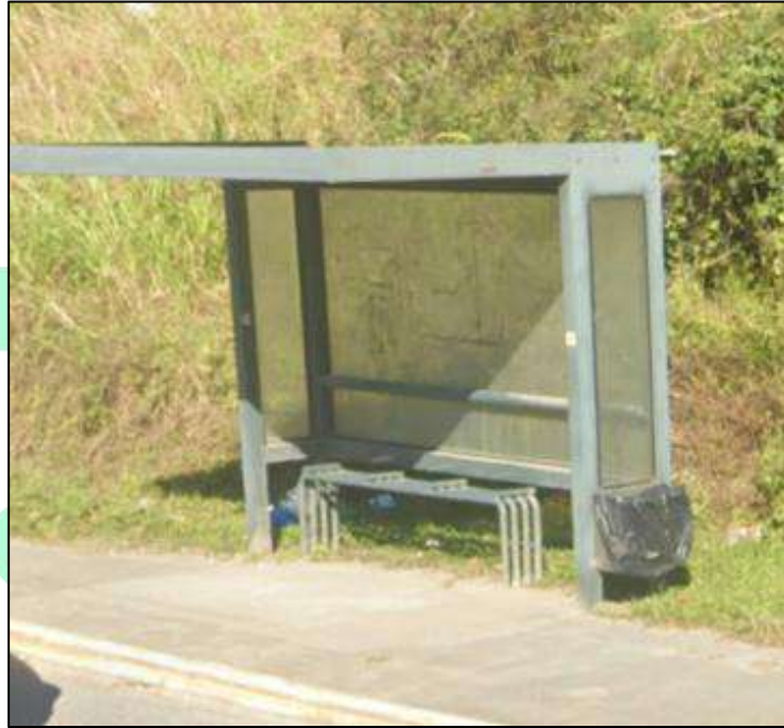
Figura 101: Detalhe do ponto de ônibus na Rua Leopoldo Beninca, lado direito, sentido centro.
