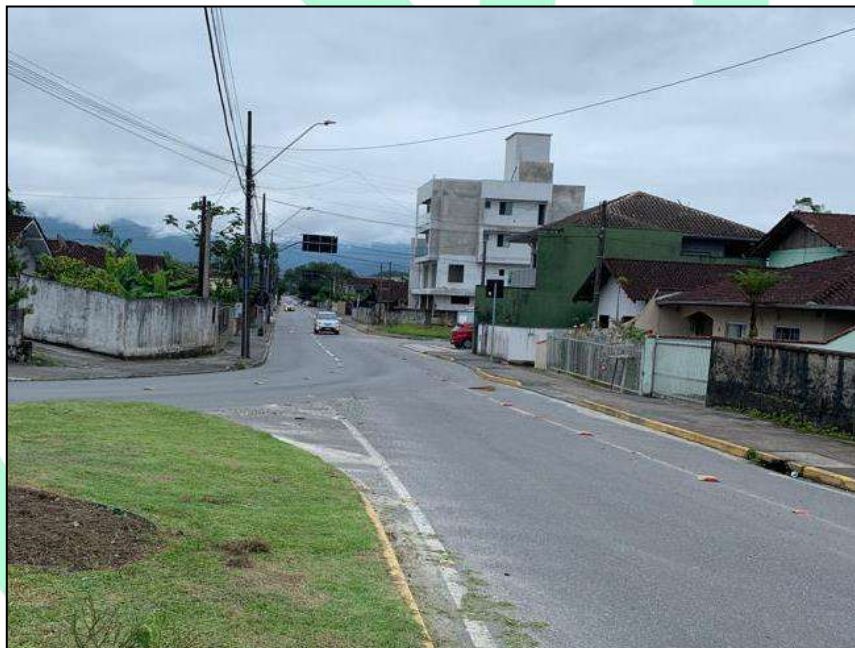
Figura 80: Rua São Firmino, visada para oeste.
