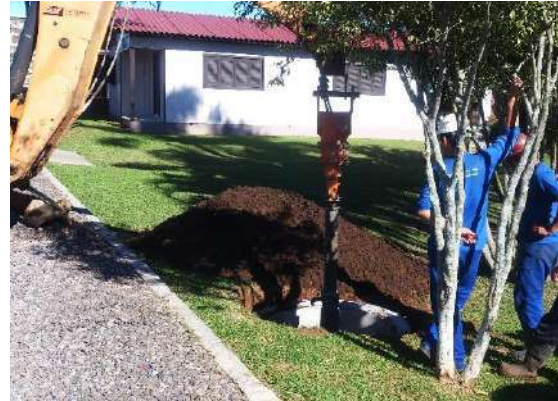
Figura 13: Exemplo de escavação para poste.
