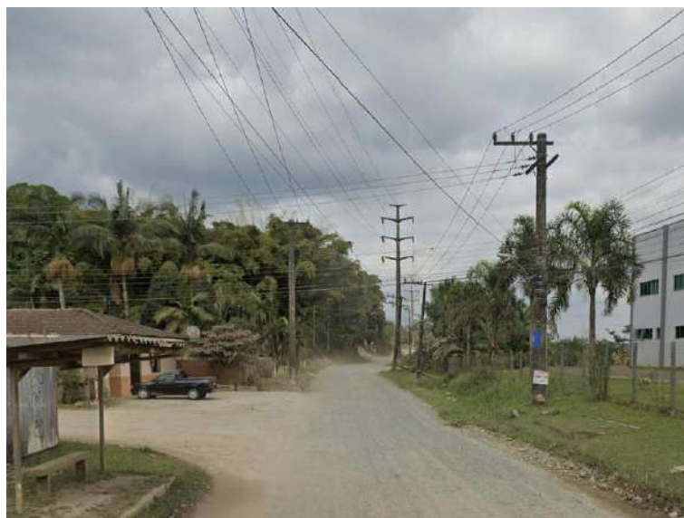
Figura 10: Vista da Rua Santa Catarina.
