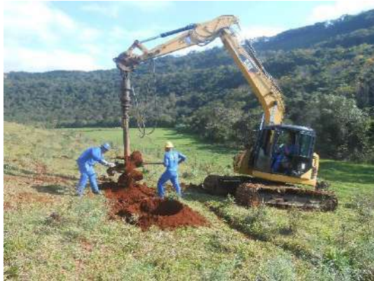
Figura 12: Exemplo de escavação do tipo tubulão.
