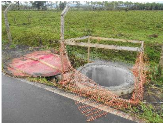
Figura 14: Exemplo de fundação para poste.
