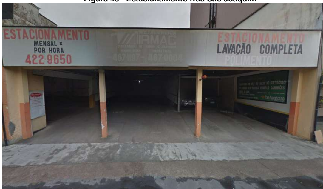
Figura 43 - Estacionamento Rua São Joaquim
