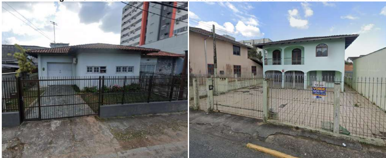
Figura 13 - Residências unifamiliares localizadas na área de influência direta
