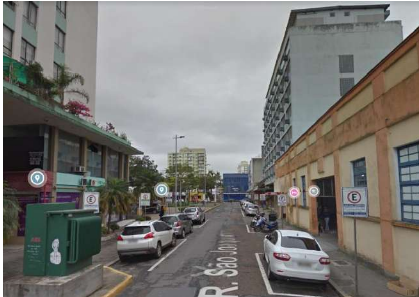
Figura 29 - Rede de abastecimento de energia elétrica subterrânea.
