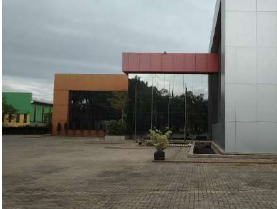
Figura 3.8 - Fachada de galpão existente, a ser mantido. Fonte: Azimute. Ano:2021.
