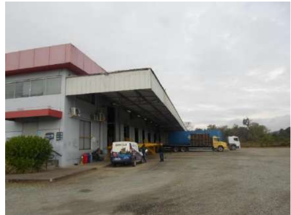
Figura 3.9 - Docas de galpão existente, a ser mantido. Fonte: Azimute. Ano:2021.
