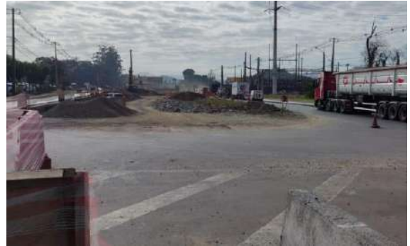
Figura 7.64 - Vista sentido rotatória “da Whirpool” a partir da via Hans Dieter Schmidt, em obras.
