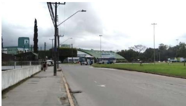
Figura 7.61 - Vista dos acessos das universidades Univille e UDESC.
