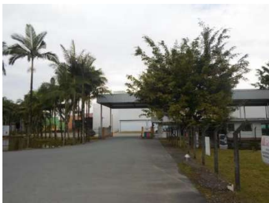
Figura 3.6 - Guarita interna de controle de acessos, à ser demolido. Fonte: Azimute. Ano:2021.
