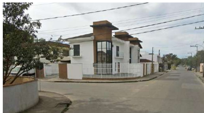
Figura 7.48 - Perfil residencial de baixa densidade nas proximidades do empreendimento. Fonte: Google Street View. Ano:2023
