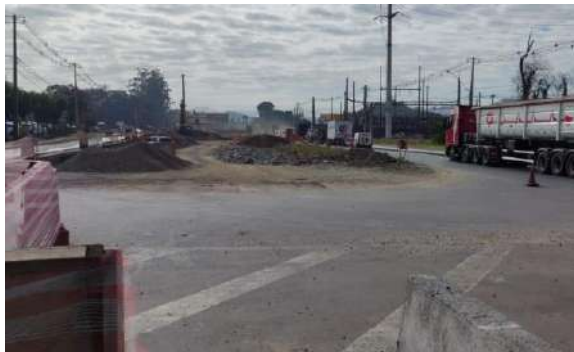
Figura 7.71 - Vista sentido rotatória "da Whirpool" a partir da via Hans Dieter Schmidt, em obras.
