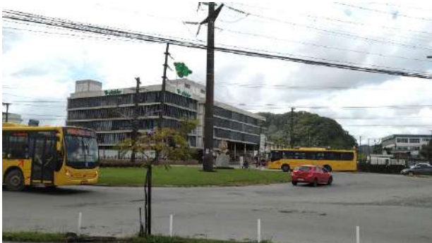
Figura 7.65 - Rótula da Dohler, cruzamento das ruas Dona Francisca, com rua Rui Barbosa, Av. Marques de Olinda e rua Arno Dohler.
