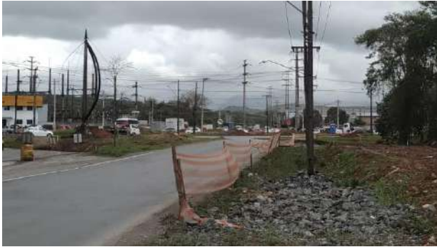
Figura 7.63 - Vista da rotatória “da Whirpool” durante as obras da Av. Edgar Nelson Meister.
