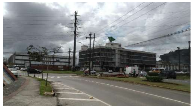
Figura 7.57 - Edifício administrativo anexo as atividades industriais da empresa Dohler na Rotatória com a rua Dona Francisca.
