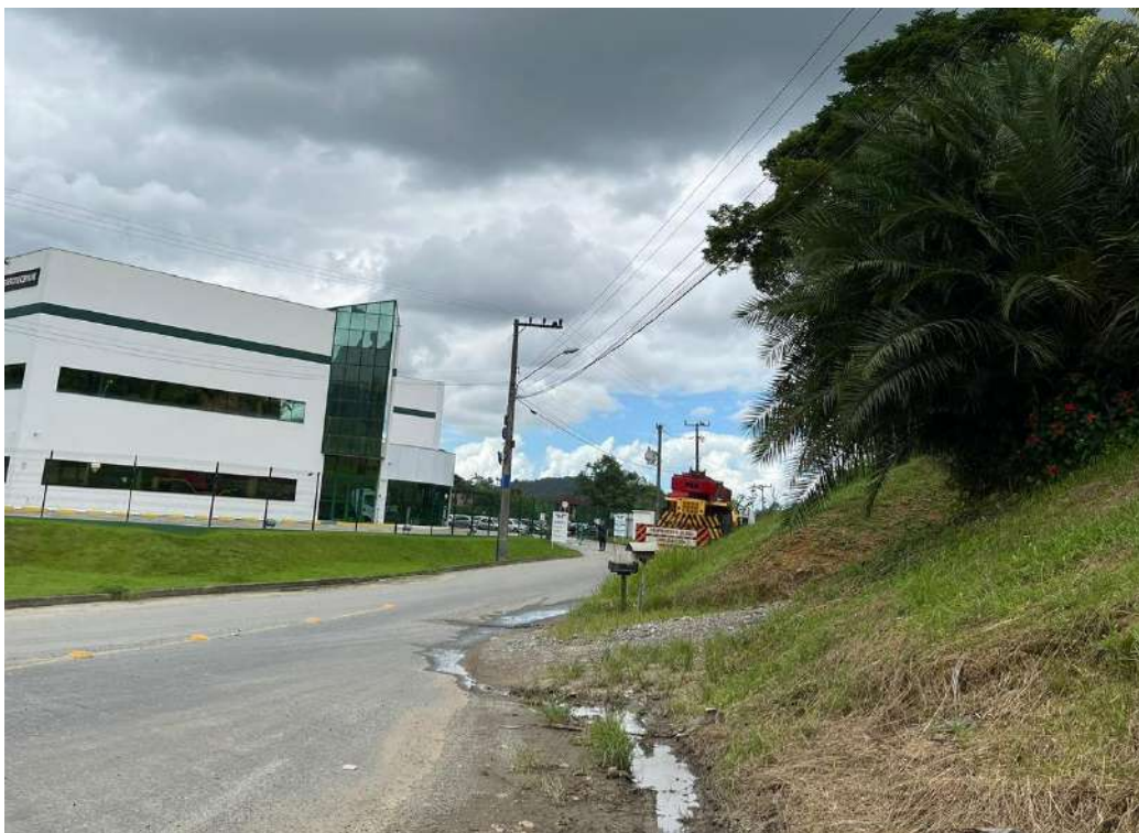
Figura 31- Rede de abastecimento de energia elétrica na Rua dos Portugueses.
