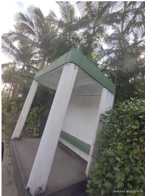
Figura 39: Abrigo tipo Concreto
