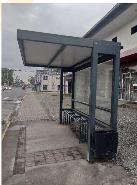
Figura 38: Abrigo tipo Vidro
