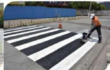
Requalificação sinalização viária
