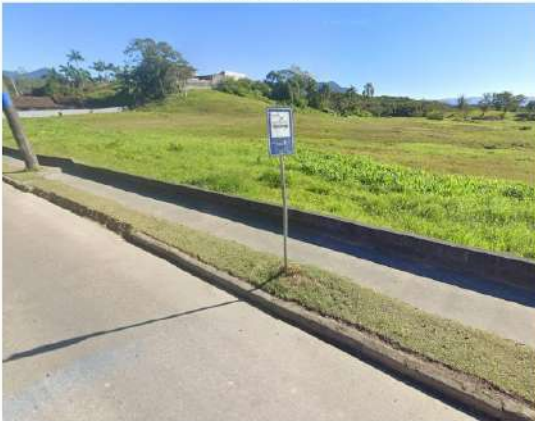
Figura 20 - Parada de ônibus existente - Rua dos Suíços
