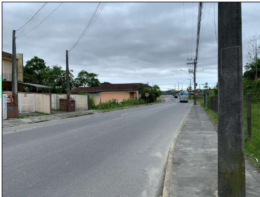
Figura 83: Rua Leopoldo Beninca, visada para leste.
