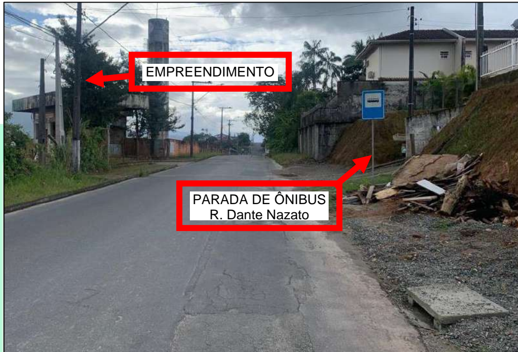
Figura 97: Parada de ônibus existente na Rua Dante Nazato, lado direito sentido R. São Firmino, em frente ao empreendimento.
