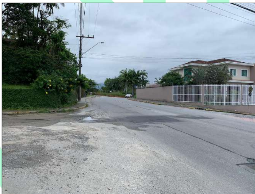
Figura 84: Rua Leopoldo Beninca, visada para oeste.
