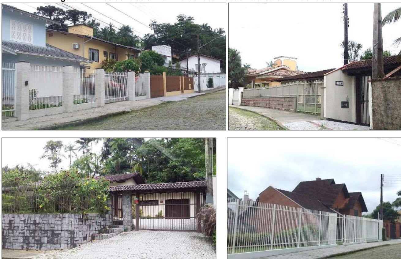
Figura 12 - Residências unifamiliares localizadas na área de influência direta
