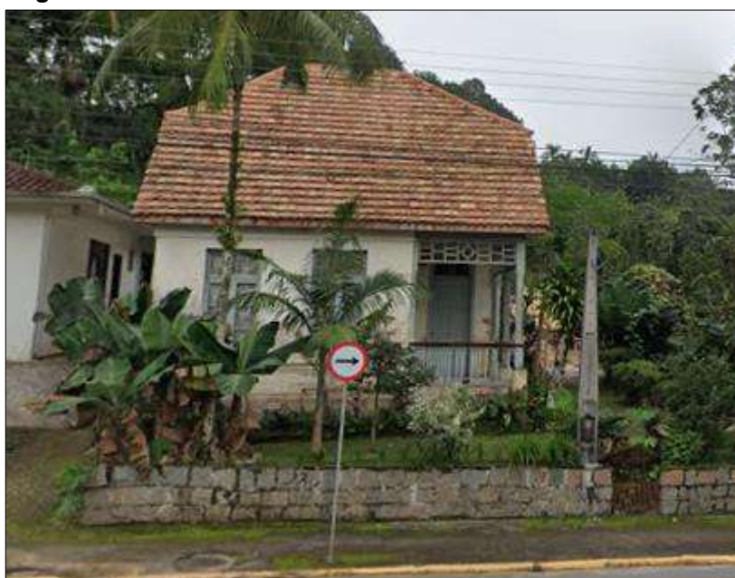
Figura 38 - Imóvel tombado localizado na Rua XV de Novembro
