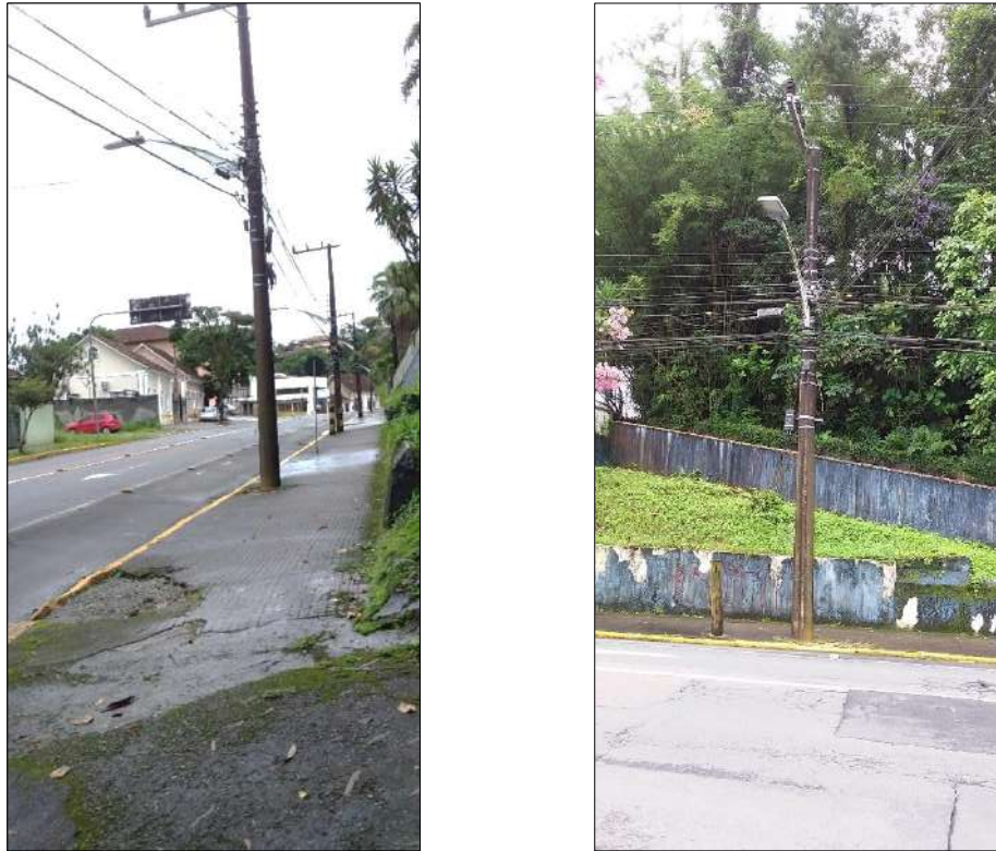
Figura 29 - Rede de abastecimento de energia elétrica na Rua Quinze de Novembro
