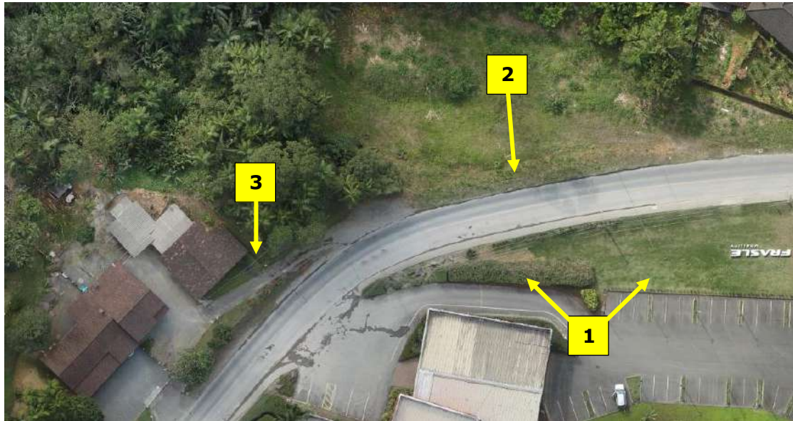
Figura 3: Talude em aclave no imóvel da FPA Adm (1). Talude em declive no imóvel na margem oposta da via (2). Rampa de Acesso ao imóvel na margem oposta da via (3).
