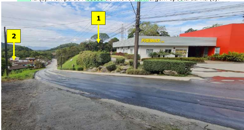
Figura 4: Talude em aclave no imóvel da FPA Adm (1). Talude em declive no imóvel na margem oposta da via (2).
