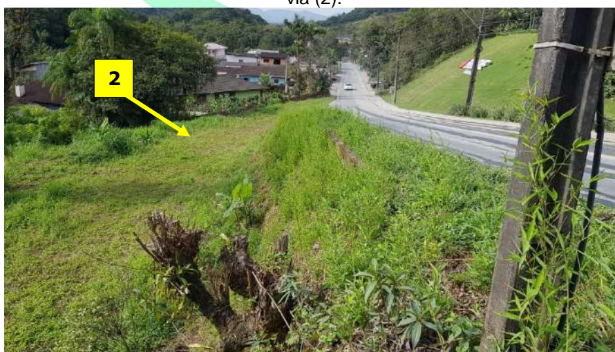
Figura 5: Detalhe do talude em declive no imóvel em frente à FPA Adm (2).
