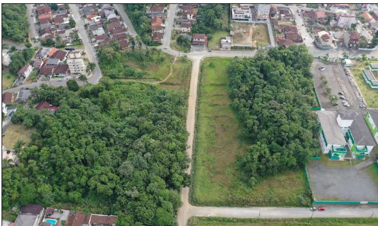
Figura 61. Ruas Erwin Seiller e Rua Jaó, com ausência de pavimentação. Fonte: DBio, 2022.
