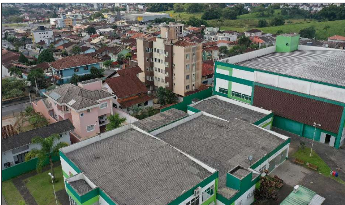
Figura 63. Tipologia das edificações no entorno do empreendimento. Fonte: DBio, 2022.
