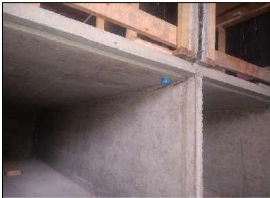
Figura 17. Impermeabilização dos lóculos (Cemitério Vertical de Maringá) Fonte: Doré Engenharia, 2020
