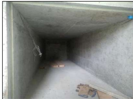
Figura 18. Imagem frontal Impermeabilização dos lóculos (Cemitério Vertical de Maringá) Fonte: Doré Engenharia, 2020
