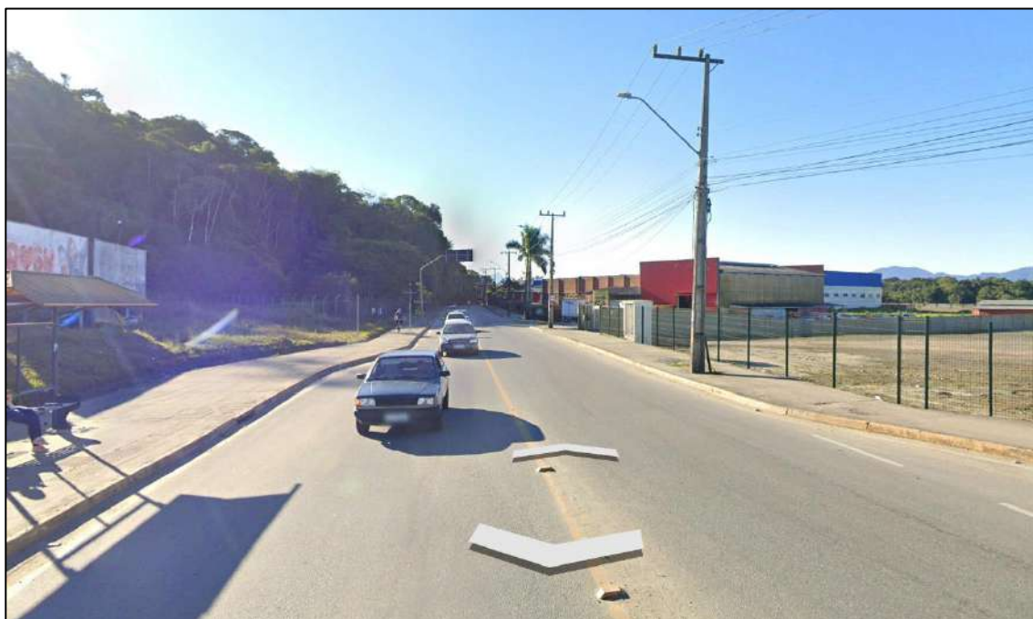
Figura 2. Via de acesso do empreendimento (Rua Tuiuti) Fonte: Doré Engenharia, 2023 – alterar e destacar a Tuiuti Imagens do google Earth
