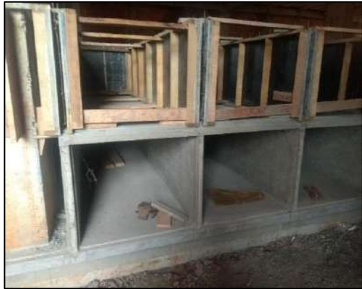
Figura 15. Lóculos em construção (modelo Cemitério Vertical de Maringá) Fonte: Doré Engenharia, 2022
