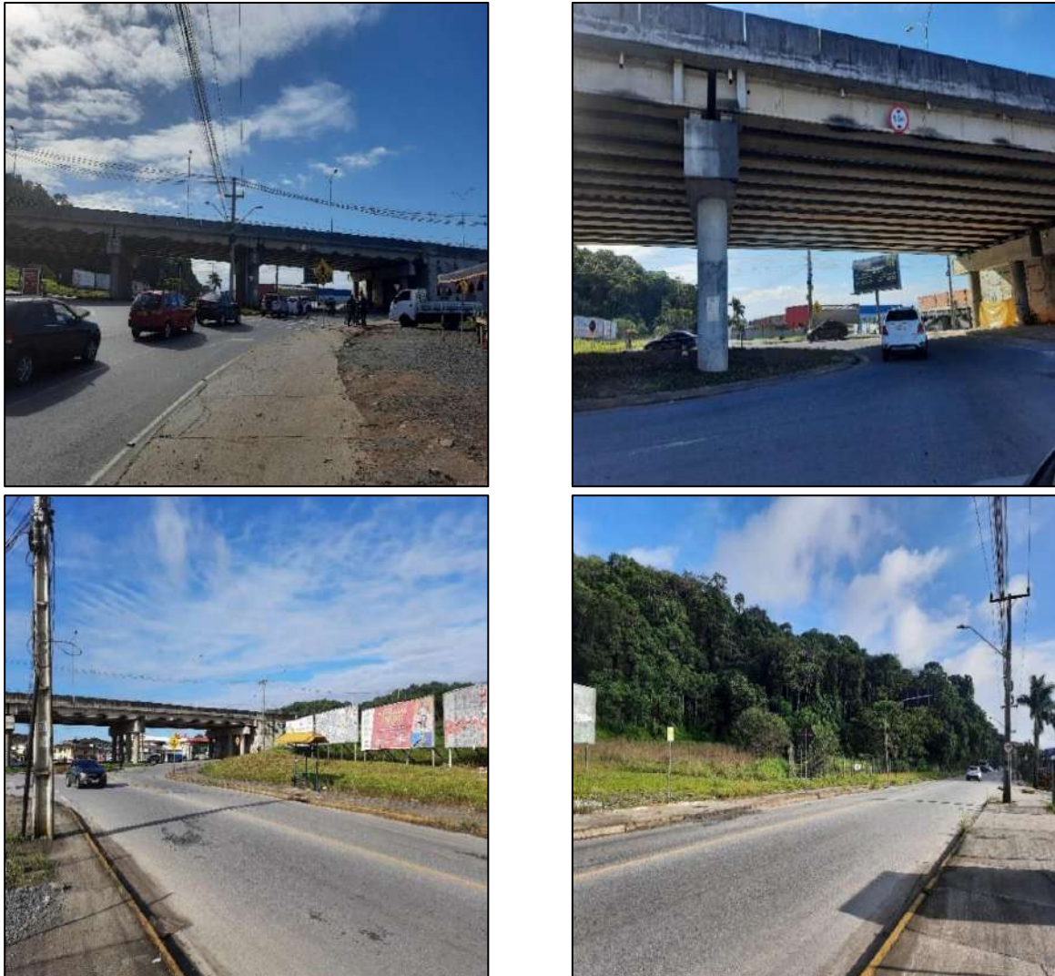
Figura 28. Pavimentação Rua Tuiuti Fonte: Prever Serviços Póstumos de Santa Catarina, 2022.
