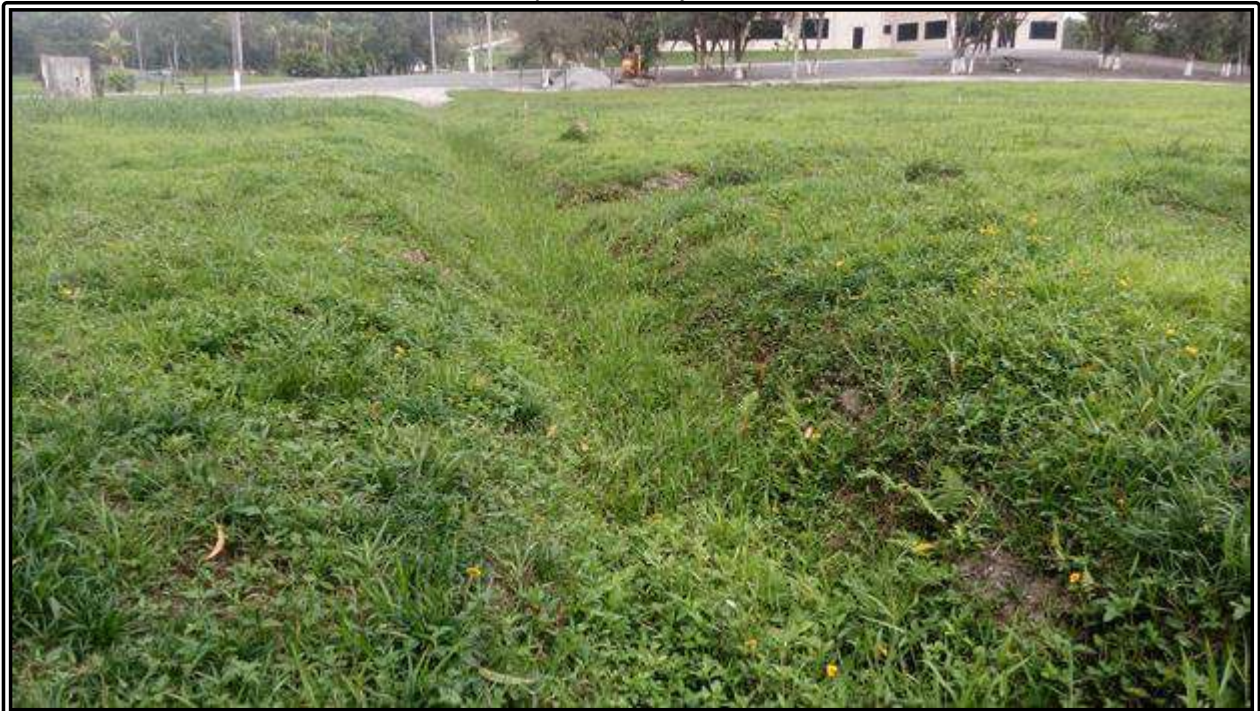
Figura 24: Vala de escoamento de caráter intermitente escavada para direcionar cargas hidráulicas para corpo hídrico à jusante
