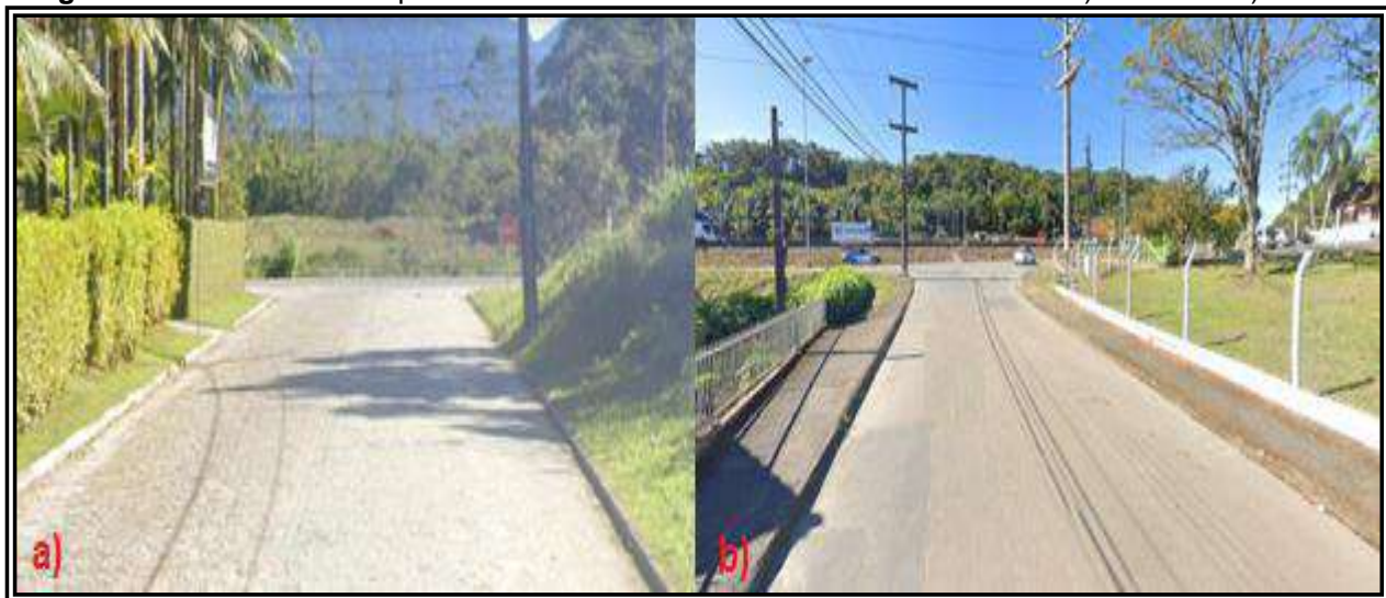
Figura 45: Estrada Arataca pavimentada nos entroncamentos com as rodovias a) SC-108 e b) BR-101
