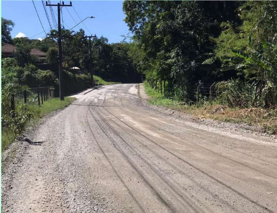
Figura 59 – Rua Anaburgo, trecho não pavimentado.
