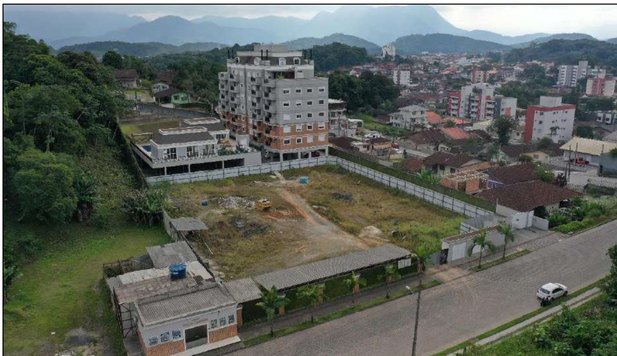
Figura 62. Tipologia das edificações no entorno do empreendimento. Fonte: DBio, 2022.
