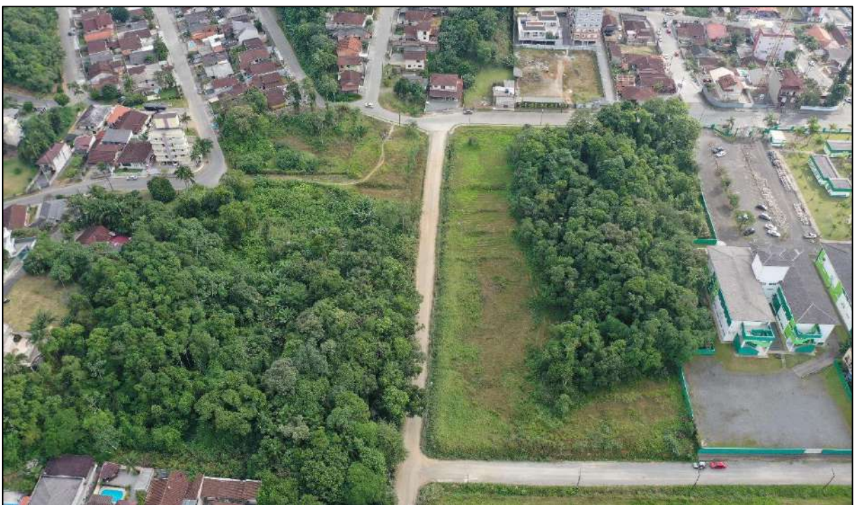
Figura 61. Ruas Erwin Seiller e Rua Jaó, com ausência de pavimentação. Fonte: DBio, 2022.
