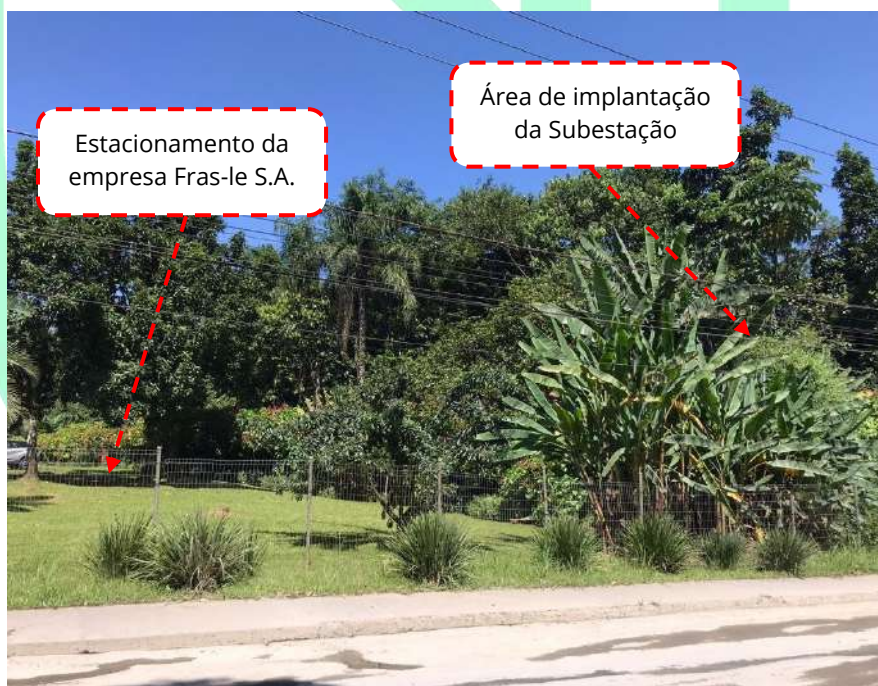
Figura 62 – Divisa da Empresa Fras-le S.A. e o local de implantação da Subestação de Energia.
