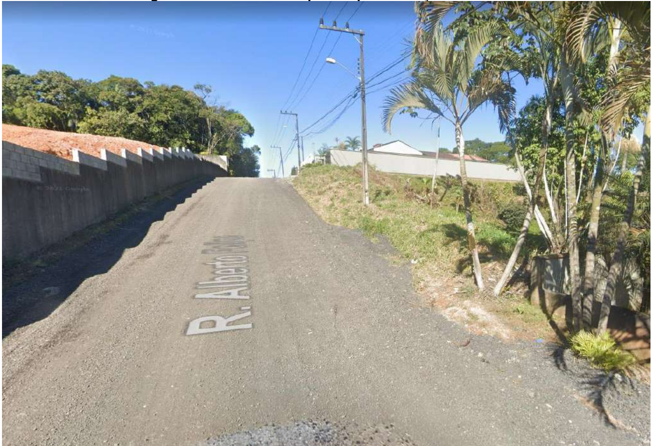
Figura 43- Rua Alberto Felipe sem pavimentação asfáltica.
