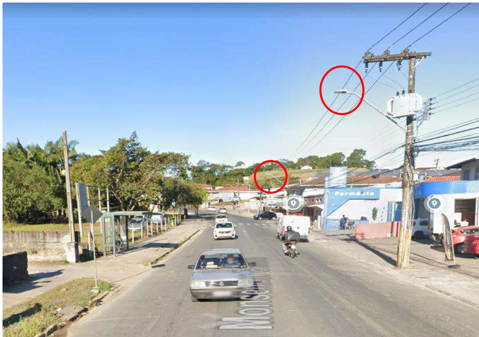
Figura 42- Sistema de iluminação pública localizada na Rua Monsenhor Gercino.
