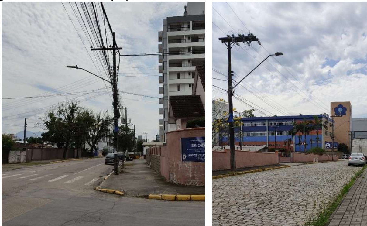
Figura 37 – Sistema de iluminação pública localizado na Rua Dona Francisca e Rua Frederico Ponick
