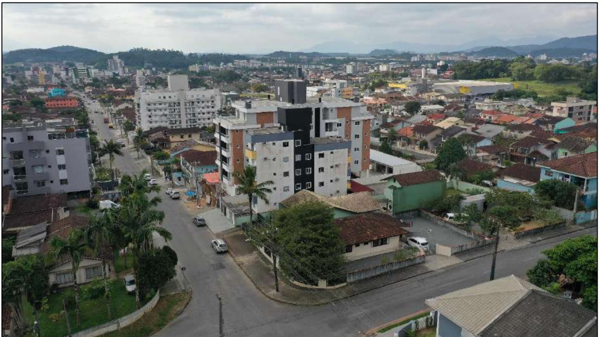
Figura 68. Tipologia das edificações no entorno do empreendimento. Fonte: DBio, 2022.
