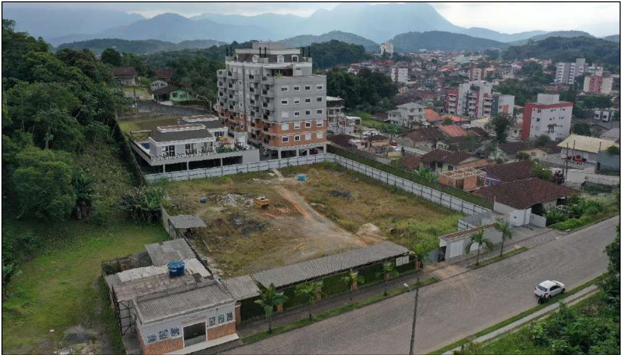
Figura 66. Tipologia das edificações no entorno do empreendimento. Fonte: DBio, 2022.
