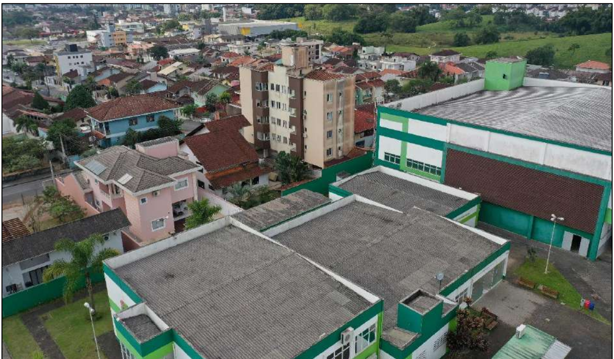
Figura 67. Tipologia das edificações no entorno do empreendimento. Fonte: DBio, 2022.
