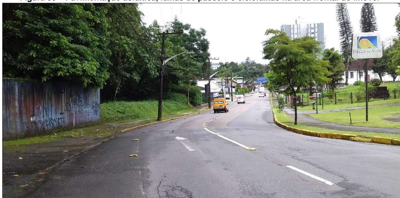
Figura 33 – Pavimentação asfáltica, faixas de passeio e ciclofaixas na área frontal do imóvel
