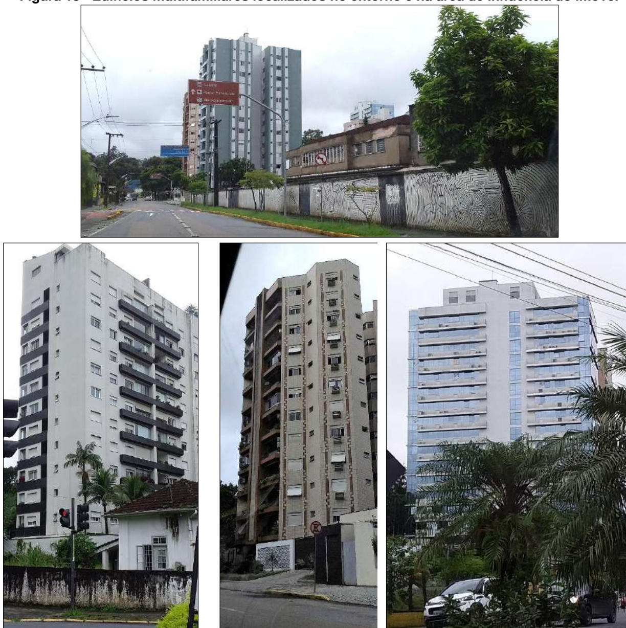
Figura 13 - Edifícios multifamiliares localizados no entorno e na área de influência do imóvel
