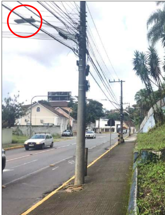
Figura 34 – Sistema de iluminação pública localizado na Rua Quinze de Novembro
