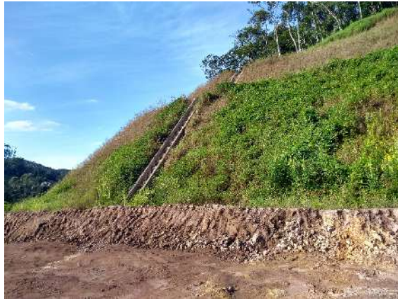
Foto 2-88: Exemplo de escada hidráulica instalada às margens de uma via de acesso, compondo o sistema de drenagem pluvial em terrenos muito íngremes e com solos frágeis. Fonte: Acervo Dossel, 2019.
