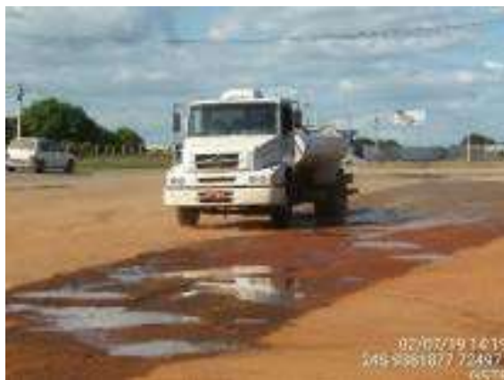
Foto 2-10: Aspersão de água com caminhão pipa para prevenção de material particulado. Fonte: Acervo CYMI, 2019.
