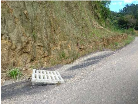
Foto 2-87: Boca coletora em estrada de acesso na região do empreendimento. Fonte: Acervo Dossel, 2019.
