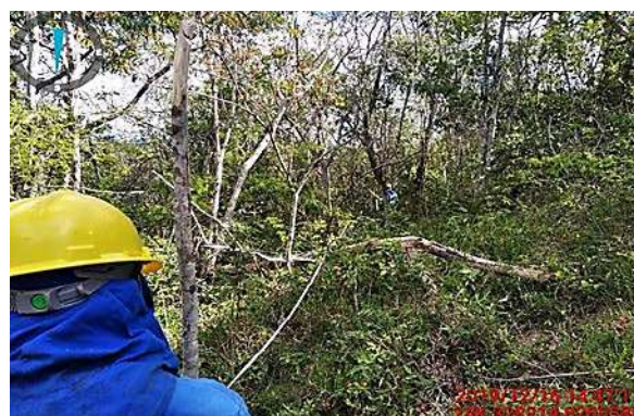
Foto 5-2: Conferência do distanciamento das marcações da topografia.
