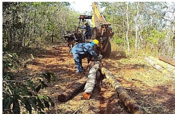
Foto 7-6: Arraste de toras utilizando retroescavadeira. Fonte: Acervo Dossel 2012.
