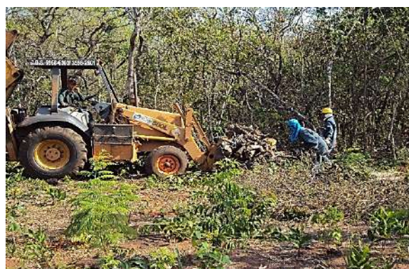
Foto 7-2: Retirada de lenha utilizando retroescavadeira. Fonte: Acervo Dossel 2012.
