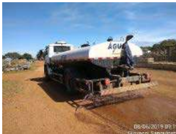
Foto 2-4: Caminhão pipa realizando umectação de via. Fonte: Acervo CYMI, 2019.
