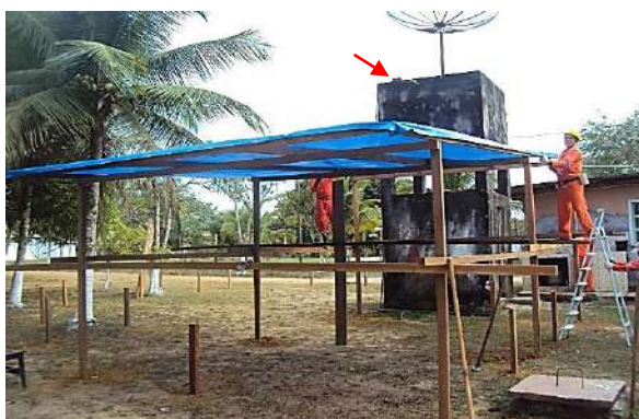
Foto 2-63: Construção da área coberta, semiaberta, de uso geral, apontando caixa de água próxima.
