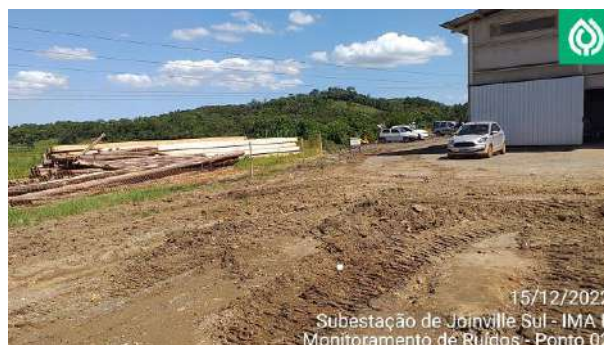
Foto 7-12: Ponto 02 do monitoramento de ruídos na SE Joinville Sul. Data: 15/12/2022.
