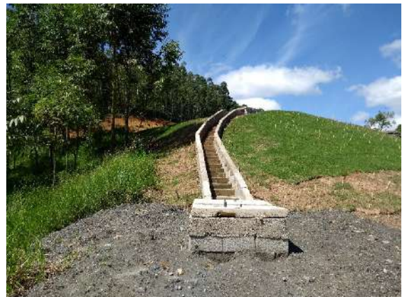
Foto 2-90: Mecanismos de proteção de encosta com escada hidráulica, caixa coletora e plantio de gramíneas. Fonte: Acervo Dossel, 2019.
