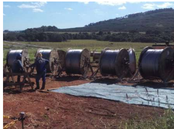
Foto 2-94: Praça de lançamento de cabos. Fonte: http://www.sogalpao.com/crp/obras/electnor/cantareira/lancamento.html ; julho/2020.
