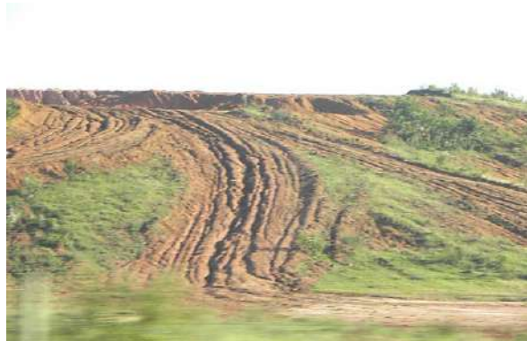
Foto 2-84: Caracterização de erosão linear rasa, associada a um terreno exposto por decapeamento superficial do solo, comprometido pela declividade e fragilidade do material exposto. Caracteriza uma condição de risco geotécnico baixo, agravada pela ação antrópica, na região do Ribeirão dos Canelas, município de Jaraguá do Sul/SC. Coord.: 22 J 681080 m E 7070615 m S.
