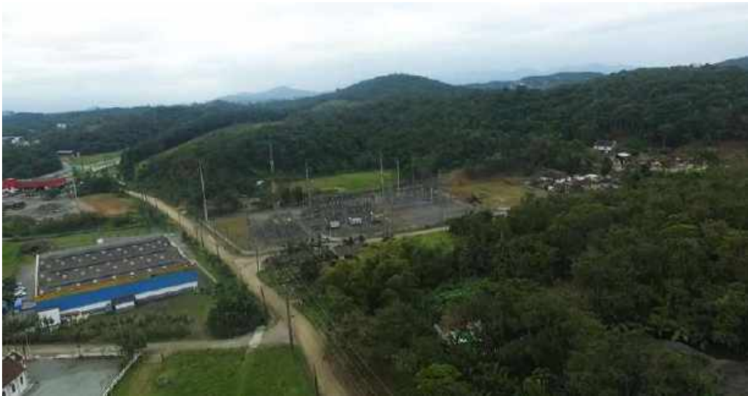
Figura 25: Área de chegada da linha na Subestação Joinville Santa Catarina (primeiro plano), composta pela unidade de Gnaisses Granulíticos Luís Alves, caracterizado pela presença de morrotes e morros baixos (segundo plano).
