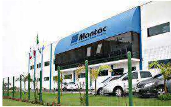
Figura 57. Vista da fábrica Mantac, ponto de referência na área do traçado. Fonte: Mantac, 2022.
