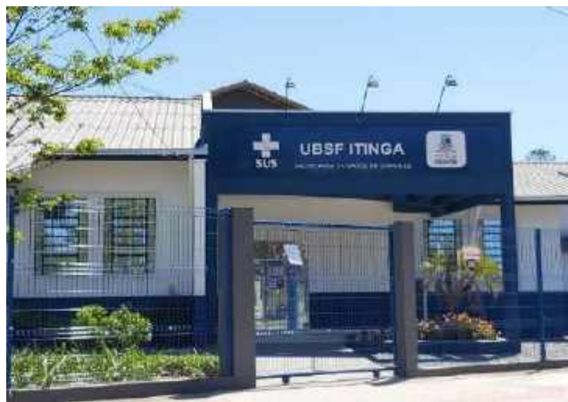
Figura 54: Unidade Básica de Saúde da Família Itinga localizada no bairro Itinga, em Joinville.
