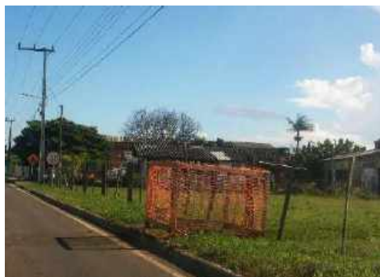
Figura 15: Área de fundação sinalizada.
