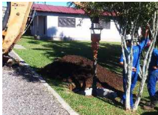
Figura 13: Exemplo de escavação para poste.
