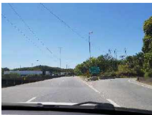
Figura 18: BR-101 acesso da Subestação Joinville Santa Catarina.
