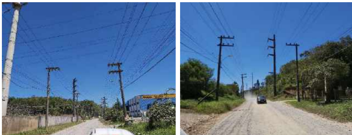
Figura 53: Estruturas existentes na área urbana transpassada pela LD.
