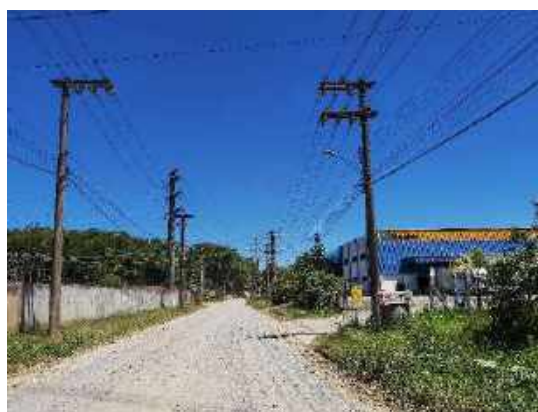
Figura 19: Rua Santa Catarina acesso da Subestação Joinville Santa Catarina.
