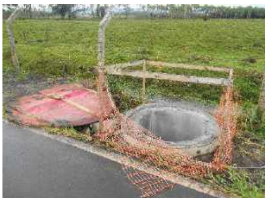
Figura 14: Exemplo de fundação para poste.
