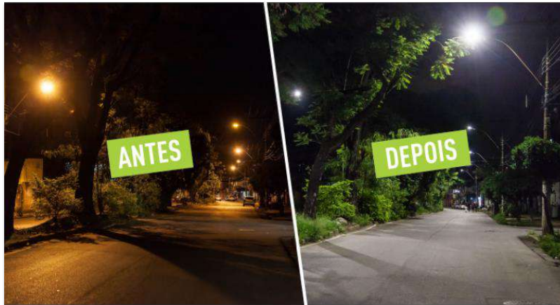
Modernização da Iluminação Pública em BH Fonte: Prefeitura Belo Horizonte (PBH)
