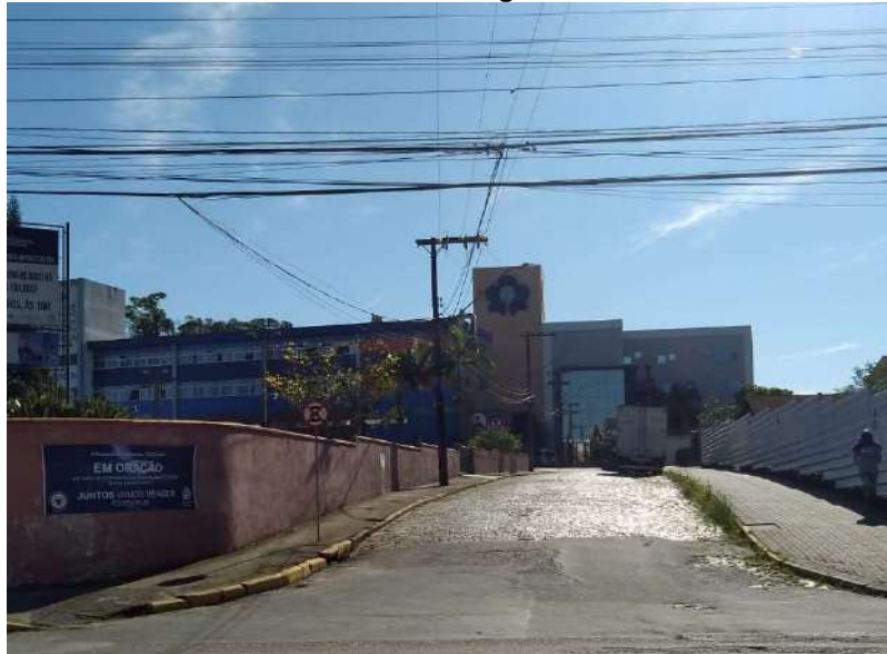
Figura 32 - Rede de abastecimento de energia elétrica na Rua Frederico Ponick
