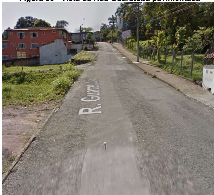
Figura 35 - Vista da Rua Guaratuba pavimentada
