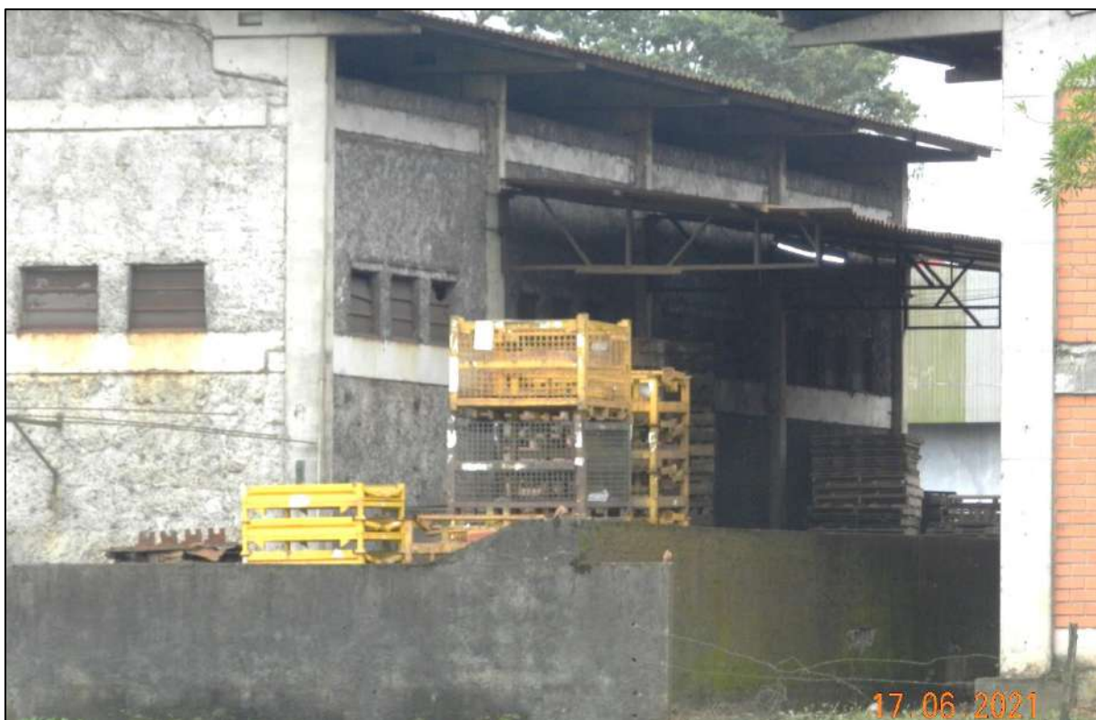
Figura 44. Empreendimento de uso industrial. Fonte: DBio, 2021.
