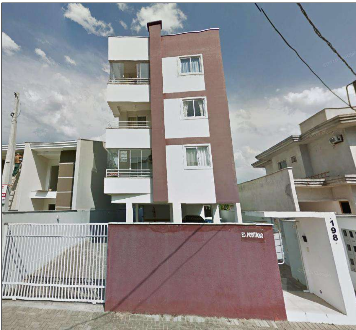
Figura 82. Tipologia de empreendimentos similares ao pretendido para o respectivo EIV. Fonte: Google Maps.
