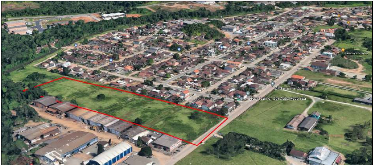
Figura 83. Evidenciando o contexto urbanizado em relação à inserção do imóvel em estudo. Fonte: Google Earth, 2022.
