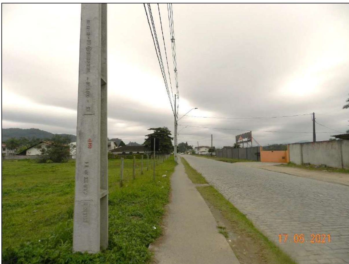
Figura 79. Rua Dorothovio do Nascimento evidenciando pavimentação. Fonte: DBio, 2022.
