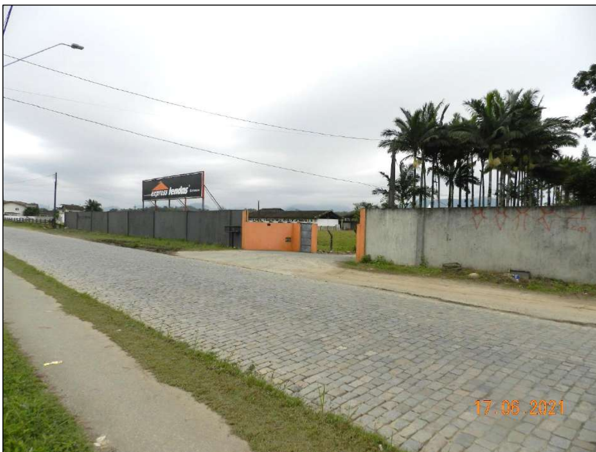
Figura 58. Rua Dorothovio do Nascimento, principal trecho de acesso ao imóvel em estudo. Detalhamento do revestimento asfáltico presente. Fonte: DBio, 2022.
