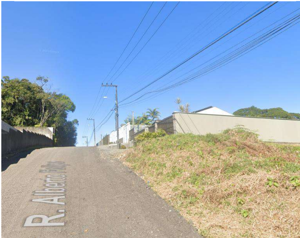
Figura 38- Rede de abastecimento de energia elétrica na Rua Alberto Felippi.
