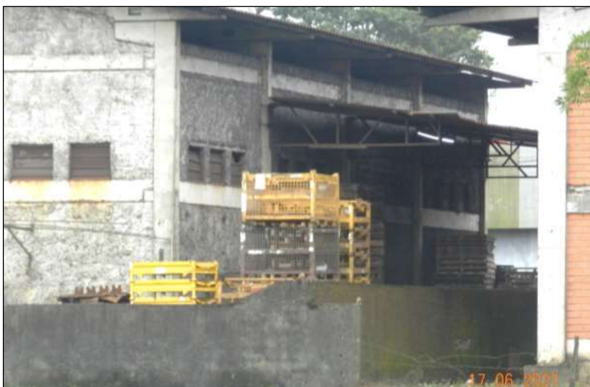
Figura 44. Empreendimento de uso industrial. Fonte: DBio, 2021.
