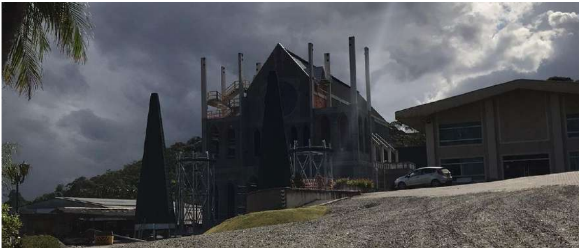
Foto 14 – Igreja Nossa Senhora do Triunfo – mais próxima do empreendimento.
