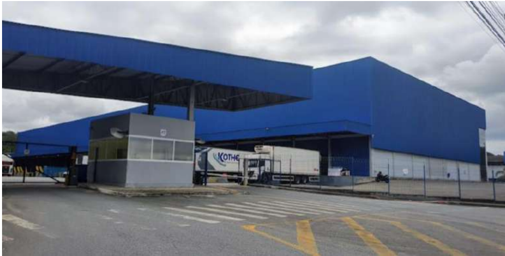
Foto 07: Terminal de carga em frente ao empreendimento
