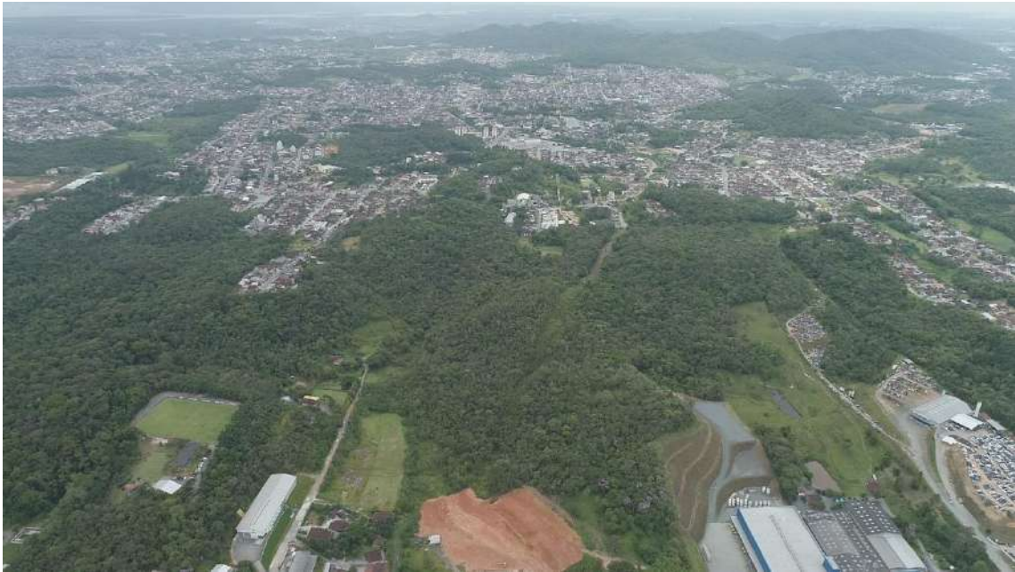
Foto 12 Vista no sentido leste da AID.
