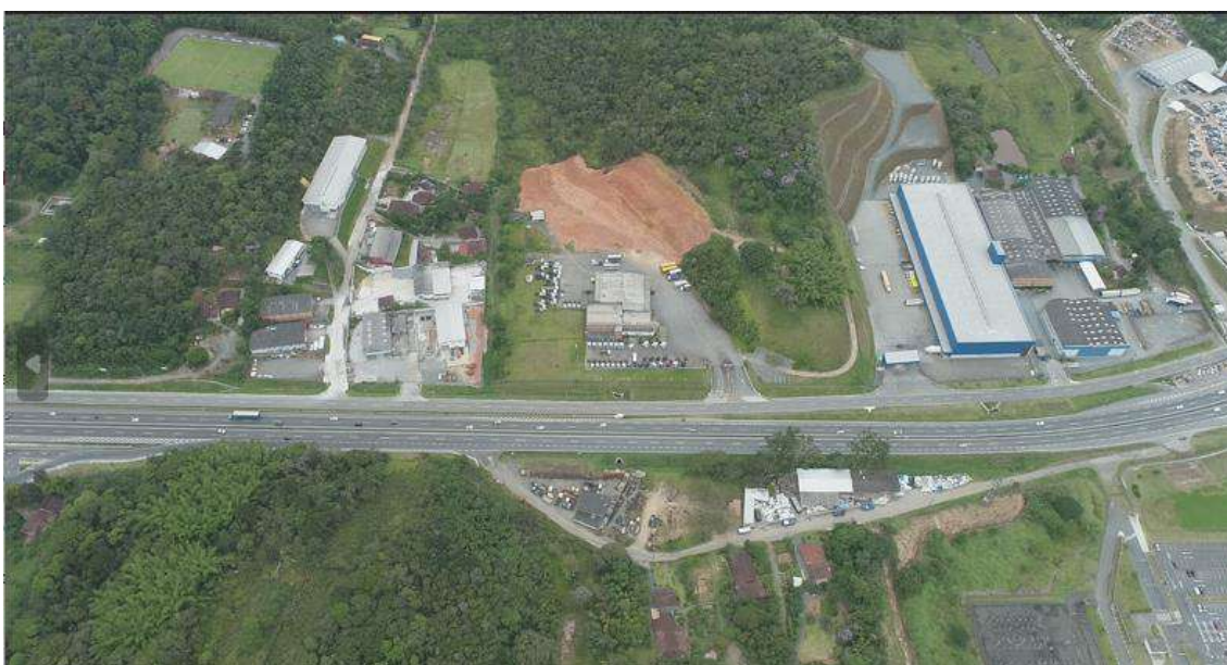
Foto 36 Vista edificações sentido Leste
