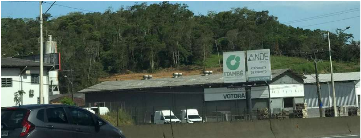
Foto 28– serviço próximo ao empreendimento.
