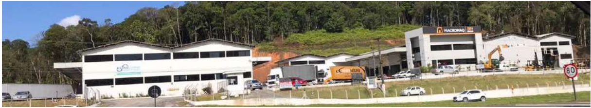
Foto 25 – serviço próximo ao empreendimento.
