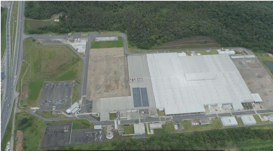
Foto 32: Imagem vista Sul – Fábrica da GM
